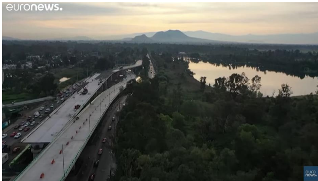
Ilustración 25: Puente en Humedal Xochimilco.
