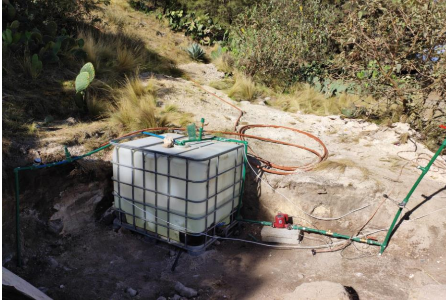
Fig. 32 "Instalación del GHE"
