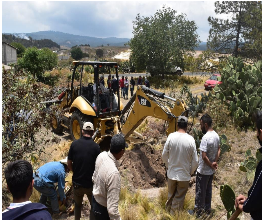
Fig. 30 "Excavación en el sitio de instalación"
