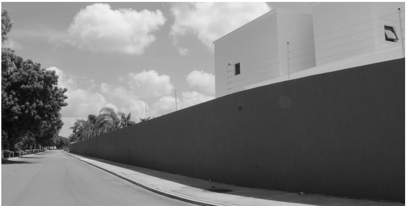
Ilustración 18. Fortificación de los CRC. Bardas perimetrales desde el exterior de los conjuntos.
