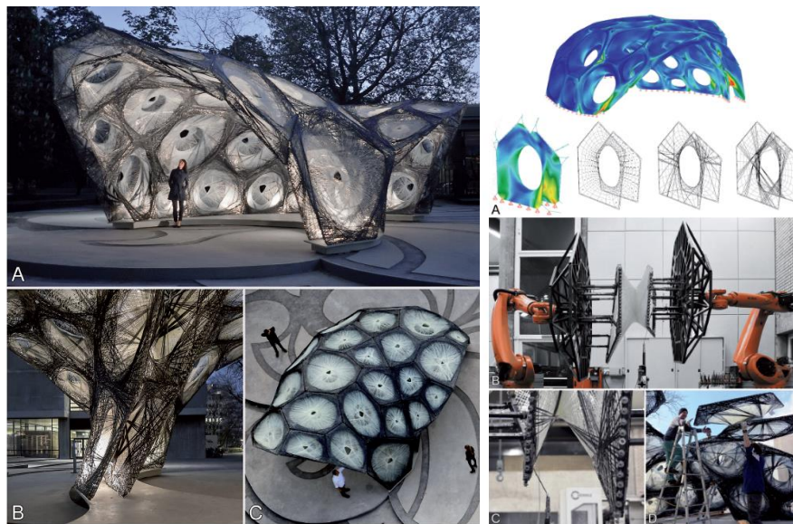
Fig. 3: Completed research pavilion at the campus of the University of Stuttgart. A Front view B View from inside; note the fiber construction and the two walls. C Top view. Abb. 3: Fertiger Forschungspavillon am Campus der Universität Stuttgart. A Vorderansicht. B Blick von innen; man beachte die Faserkonstruktion und die beiden Wände. C Aufsicht.
