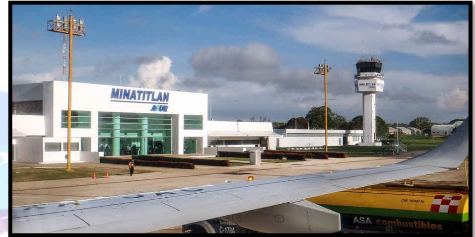
Fig.9. Aeropuerto de Minatitlán, Aeropuerto Minatitlán, 2017
