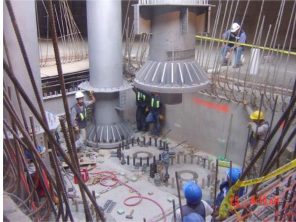
**Imagen 12.** Montaje de las columnas de acero en dado de cimentación
