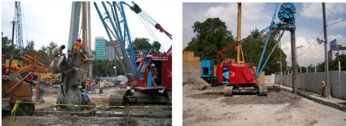
**Imagen 9.** Trabajos de excavación para la cimentación y muro milán de la Estela de Luz.
