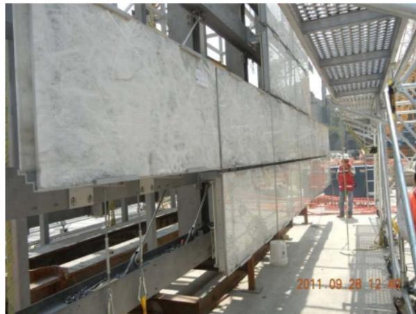
**Imagen 13.** Colocación de cuarzo en estructura de acero inoxidable
