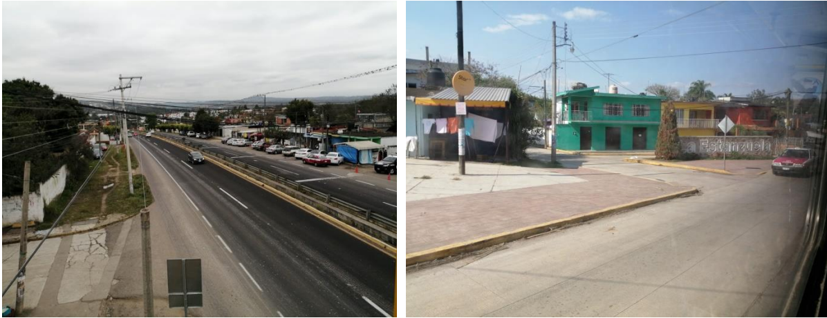
Imagen 24. Vías de comunicación en el municipio de Emiliano Zapata. Carretera Federal 140 en Dos Ríos (izquierda) y Carretera Coatepec-Las Trancas en Estanduela (derecha). Fuente: recorrido en campo
