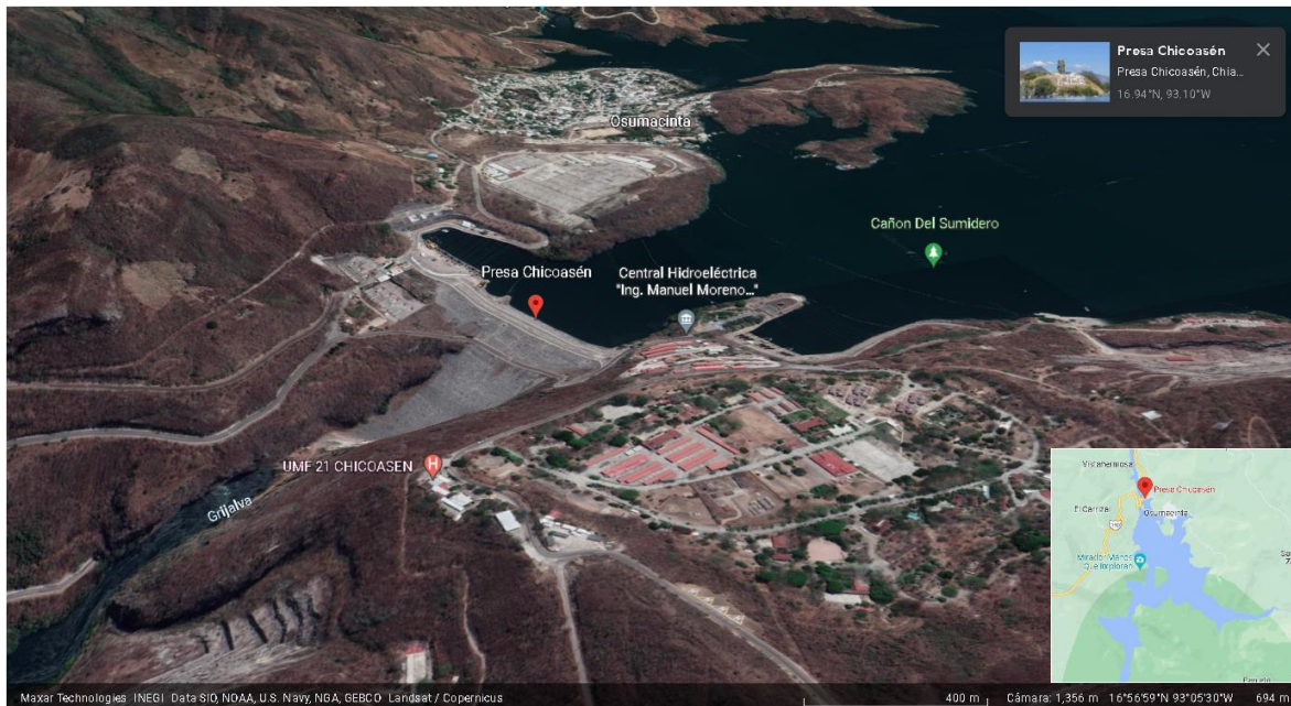
Figura 2.4 Presa Manuel Moreno Torres “Chicoasén”. Fuente: Imagen de Google Earth (2022)
