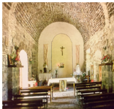
Figura 92. Nave del templo de San José de Comondú, con bóveda de tezontle. Fotografía tomada de: Edward W. Vernon, Las Misiones Antiguas... 59.
