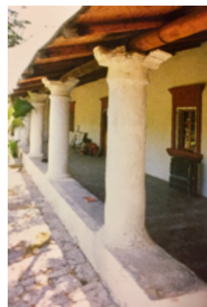
Figura 53. Columnas de piedra soportando un techo en el rancho La Presa. Fotografía tomada de: Edward W. Vernon, Las Misiones Antiguas... 156.
