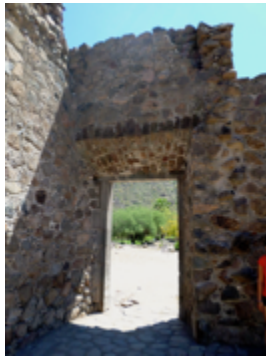
Figura 166. Vano en un muro a medio terminar en la misión de San Francisco Xavier Viggé-Biaundó. Fotografía: Leonardo Varela.
