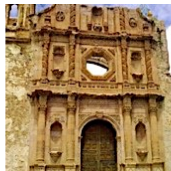
Figura 178. Portada principal del templo del convento de San Francisco, Zacatecas. Fotografía tomada de: https://programadestinosmexico.com/que-ver/arquitectura-colonial/arquitectura-colonial-en-zacatecas.html
