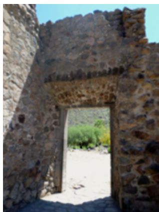
Figura 97. Muro en los anexos de San Francisco Xavier Viggé- Fotografía: Leonardo B. Varela Cabral.
