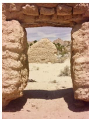
Figura 84. Vano de un edificio en Santa María de los Ángeles Kabujakaamang. Fotografía tomada de: Edward W. Vernon, Las Misiones Antiguas... 192.
