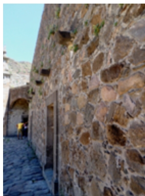
Figura 75. Muro en la zona oriente de los anexos del templo de San Francisco Xavier Viggé-Biaundó. Fotografía: Leonardo B. Varela Cabral.
