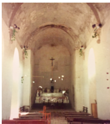
Figura 91. Nave del templo de San Luis Gonzaga, con bóveda de ladrillo encalado. Fotografía tomada de: Edward W. Vernon, Las Misiones Antiguas... 145.
