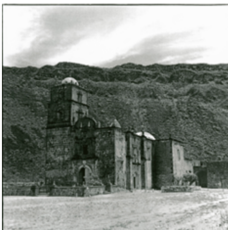
Figura 156. George E. Lindsay. Templo de la misión de San Francisco Xavier Viggé-Biaundó, apreciándose del lado derecho parte de un edificio anterior, 1938. Fotografía tomada de: Archivo Histórico Pablo L. Martínez de Baja California Sur (AHPLM-BCS).
