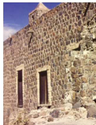
Figura 98. Muro del templo de Santa Rosalía de Mulegé. Fotografía tomada de: Edward W. Vernon, Las Misiones Antiguas... 48.
