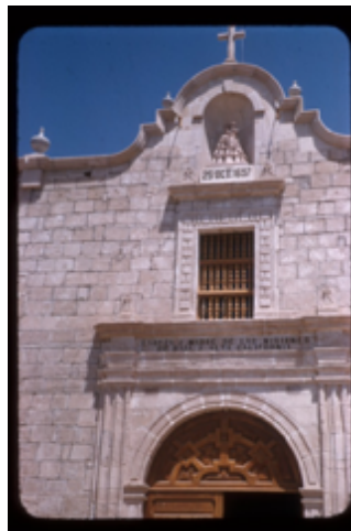
Figura 112. Howard E. Gulick. Fachada del templo de la misión de Loreto, 1957. Fotografía tomada de: University of California-San Diego Library, disponible en: https://library.ucsd.edu/dc/object/bb3789249c
