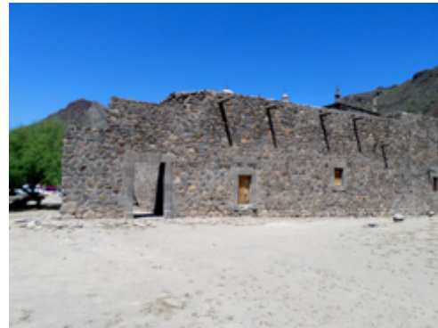
Figura 167. Muro a medio terminar en la misión de San Francisco Xavier Viggé-Biaundó. Fotografía: Leonardo Varela.
