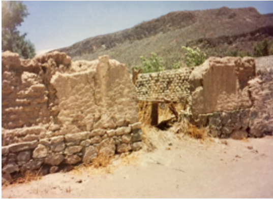
Figura 78. Restos de muros con cimentación en la visita de San Miguel, cercana a San José de Comondú. Fotografía tomada de: Edward W. Vernon, Las Misiones Antiguas... 55.
