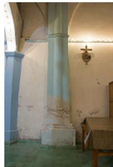
Grieta en el piso del coro que continúa en el basamento de la pilastra del eje 2-2
