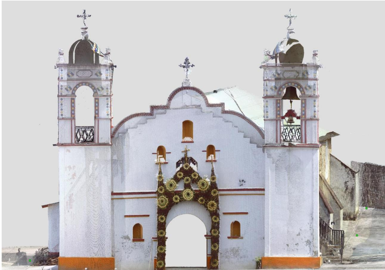
Imagen núm. 25. Fachada principal del templo, fotografía rectificada con la nube de puntos, obtenida del levantamiento con escáner láser. AMLG abril 2016.
