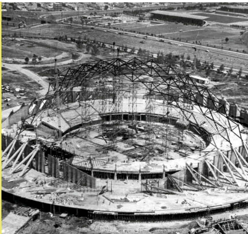
7. Construcción del Palacio de los Deportes .Foto: VivaBasquet
