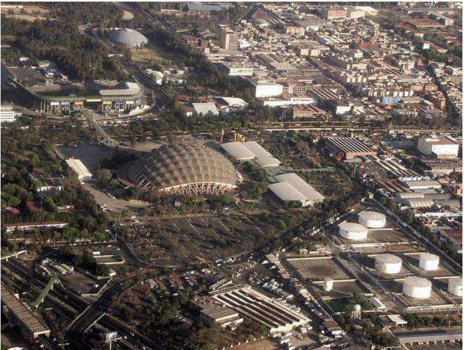
4. Vista aérea Palacio de los Deportes. Foto: Slideshare
