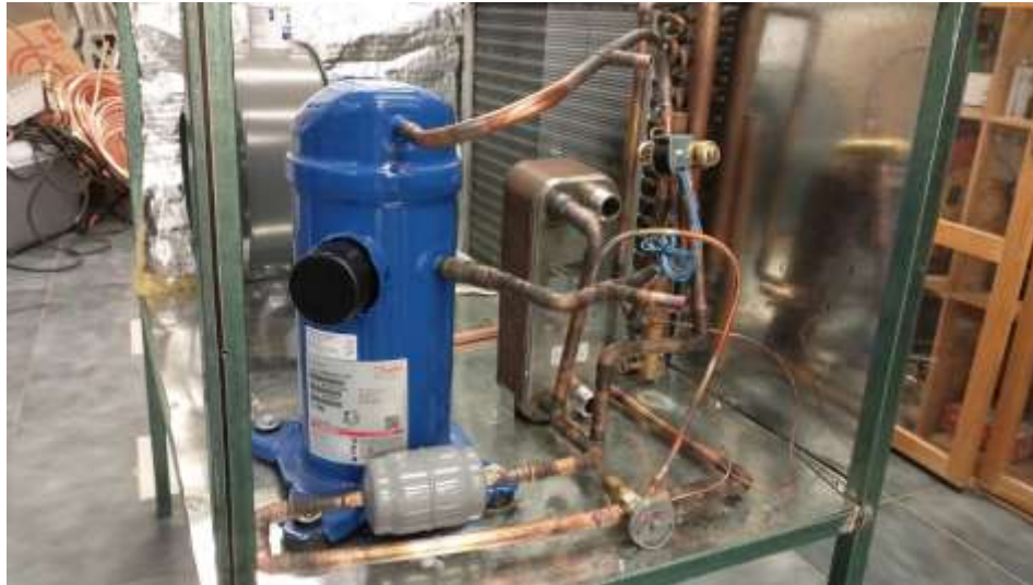
Imagen 154 Arreglo final de tuberías
