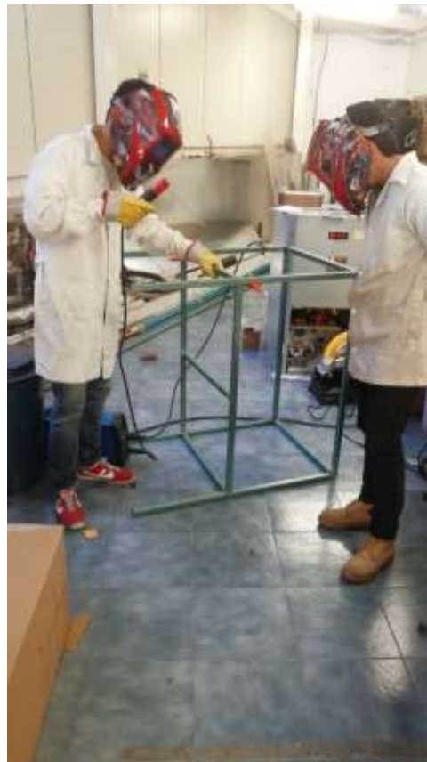
Imagen 138 Proceso de soldar la estructura de PTR
