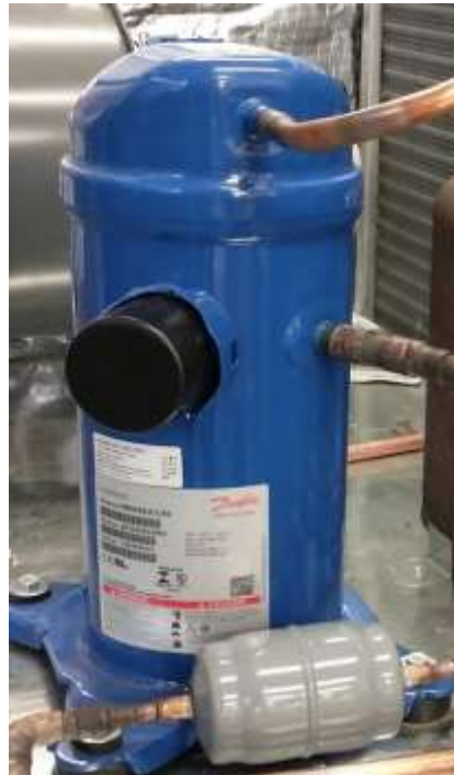
Imagen 116 Compresor Danfoss HRH036U1 (Equipo dentro de la BCG 3 TR)
