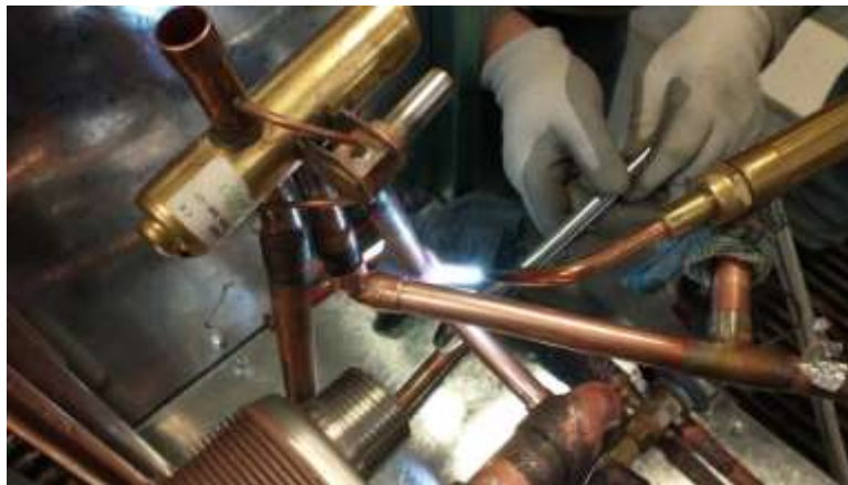
Imagen 152 Instalación de las tuberías salientes de la válvula de cuatro vías por oxiacetileno
