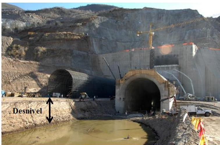
Imagen 4. 5 Desnivel en túneles de desvío en la presa La Yesca.
