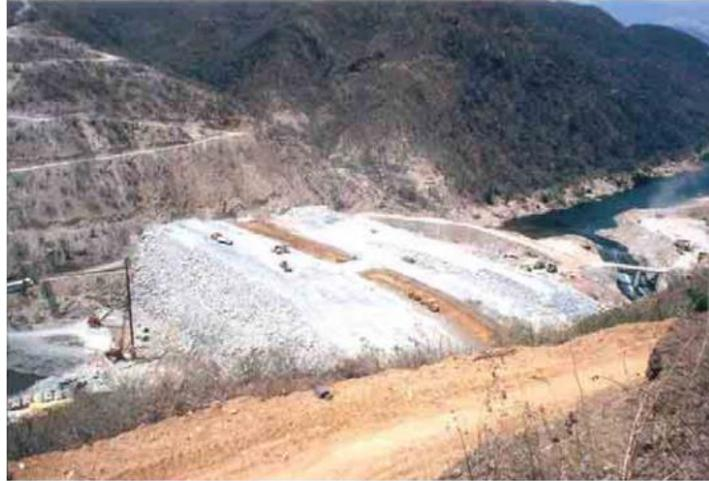
Imagen 3. 1 Construcción de ataguía tipo terraplén en la presa El Cajón, Nayarit, México.
