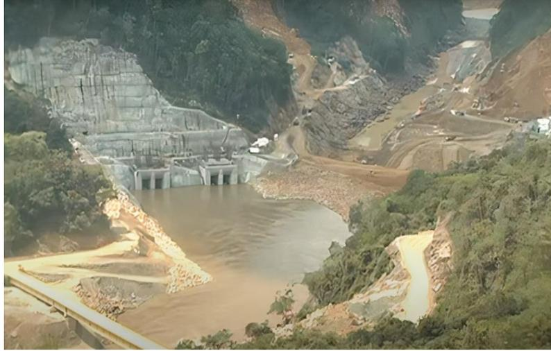
Figura 6. 10 Manejo del río Sogamoso por los túneles de desvío, Colombia.
