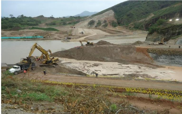
Figura 6. 8 Excavación del canal de llamada en el desvío del río Magdalena, Colombia.
