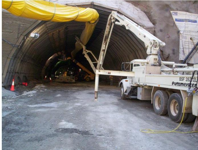
Figura 6. 4 Excavación de túnel de desvío en la presa La Yesca.
