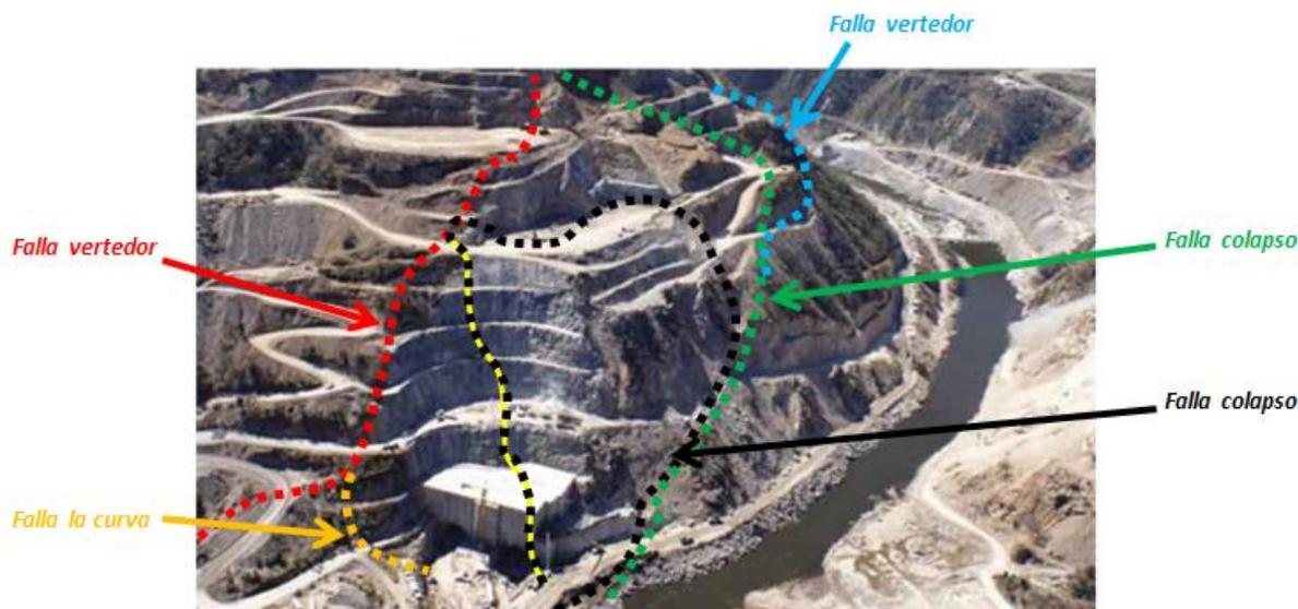
Imagen 8. 2 Vista de las fallas presentes en el proceso constructivo de los túneles de desvío en la presa La Yesca.
