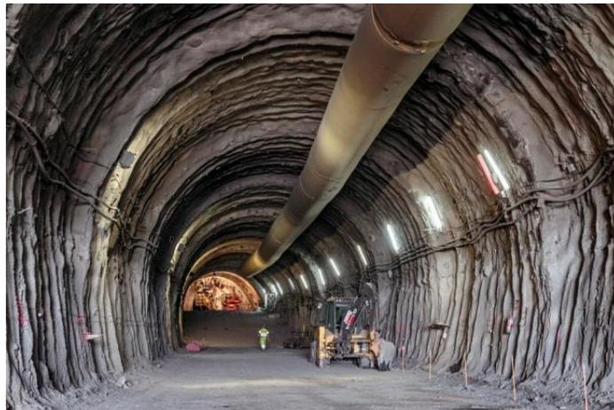
Figura 8. 4 Construcción de túnel de desvío.
