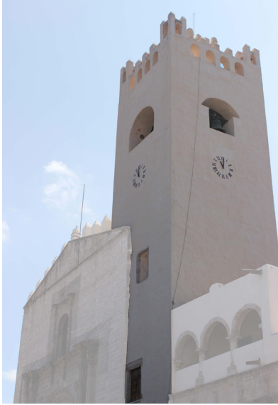
Figura 52. Torre del conjunto. Fotografía tomada el 16 de julio de 2022.
