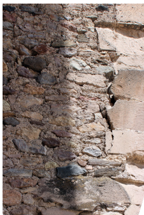
Figura 82. Detalle de muro exterior. Fotografía tomada el 16 de julio de 2022.
