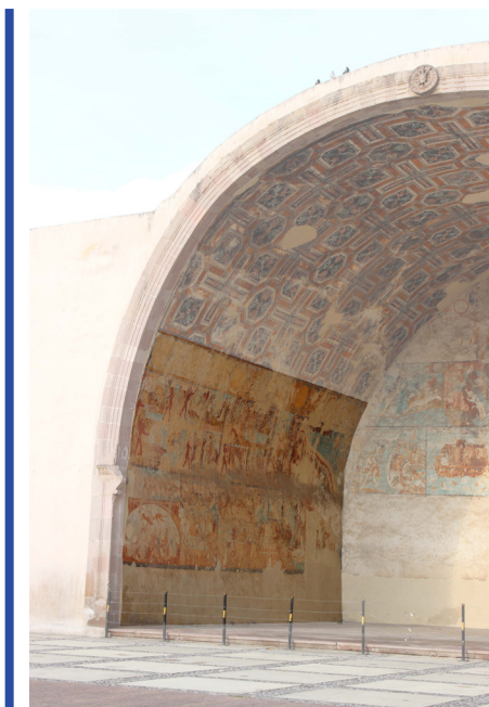
Figura 45. Muro norte de la capilla abierta. Fotografía tomada el 16 de julio de 2022.
