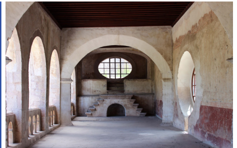
Figura 66. Interior del anexo. Fotografía tomada el 16 de julio de 2022.
