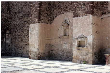
Figura 34. Ejemplo de materiales constructivos. Fotografía tomada el 16 de julio de 2022.
