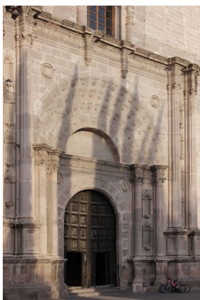
Figura 51. Fachada principal. Fotografía tomada el 16 de julio de 2022.
