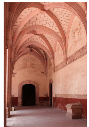
Figura 59. Pasillo del claustro. Fotografía tomada el 16 de julio de 2022.
