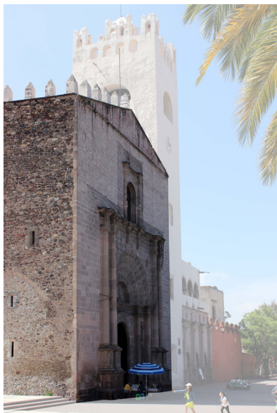
Figura 50. Vista general del templo. Fotografía tomada el 16 de julio de 2022.
