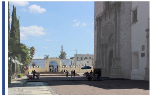
Figura 36. Vista oeste del atrio. Fotografía tomada el 16 de julio de 2022.
