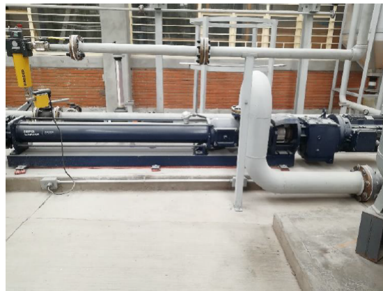
Figura 3.5: Bomba de cavidad progresiva (Hernández, 2019).
