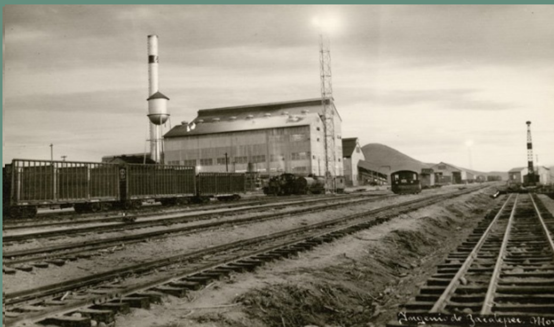
Nota. Escobar, A. (1940). Ingenio de Zacatepec junto a las vías (Foto). colección Aurelio Escobar, Mediateca del INAH
