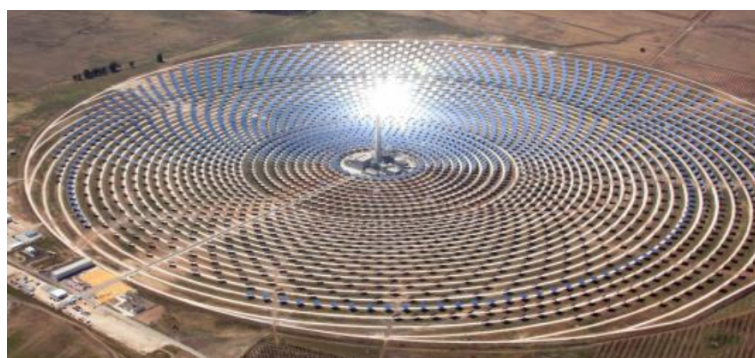
Figura 2.13: Gemasolar, Planta de Torre Central, España ( SENEREnergy 2011 ).
