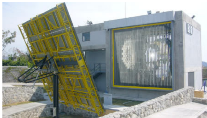
Figura 2.17: Horno Solar de Alto Flujo Radiativo del Instituto de Energías renovables (HoSIER) ( Estrada et al. 2015 ).
