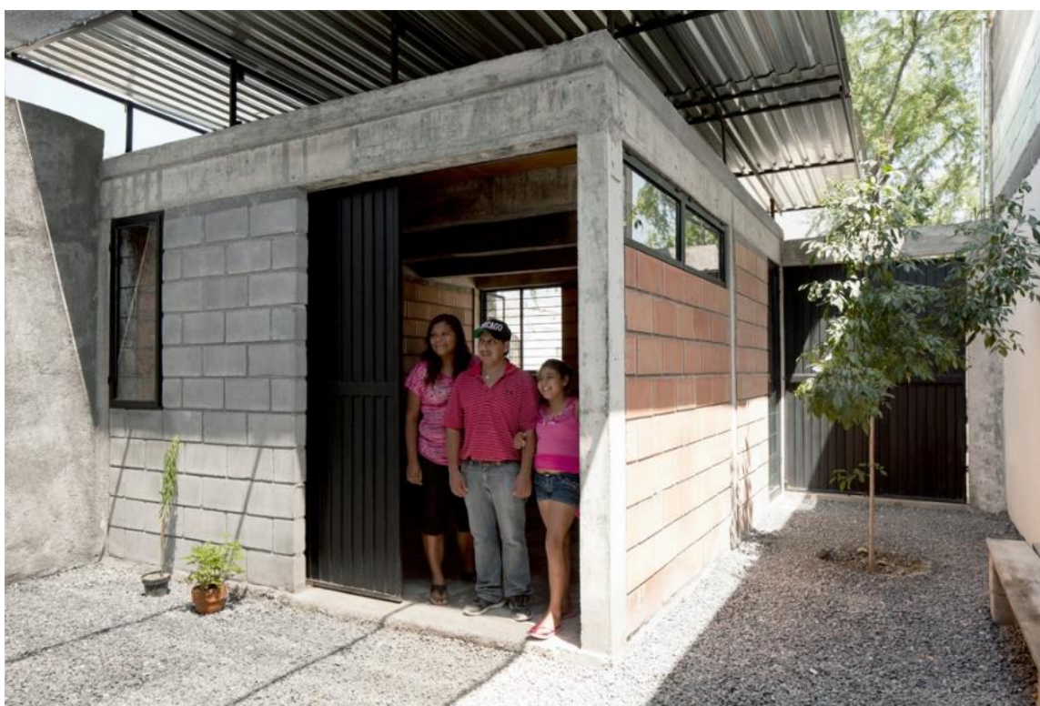
Imagen 36. Proyecto Casa Cubierta del programa Vivienda Social Unifamiliar, para familias de escasos recursos Fuente, fotografía propiedad de Ana Cecilia Garza Villareal
