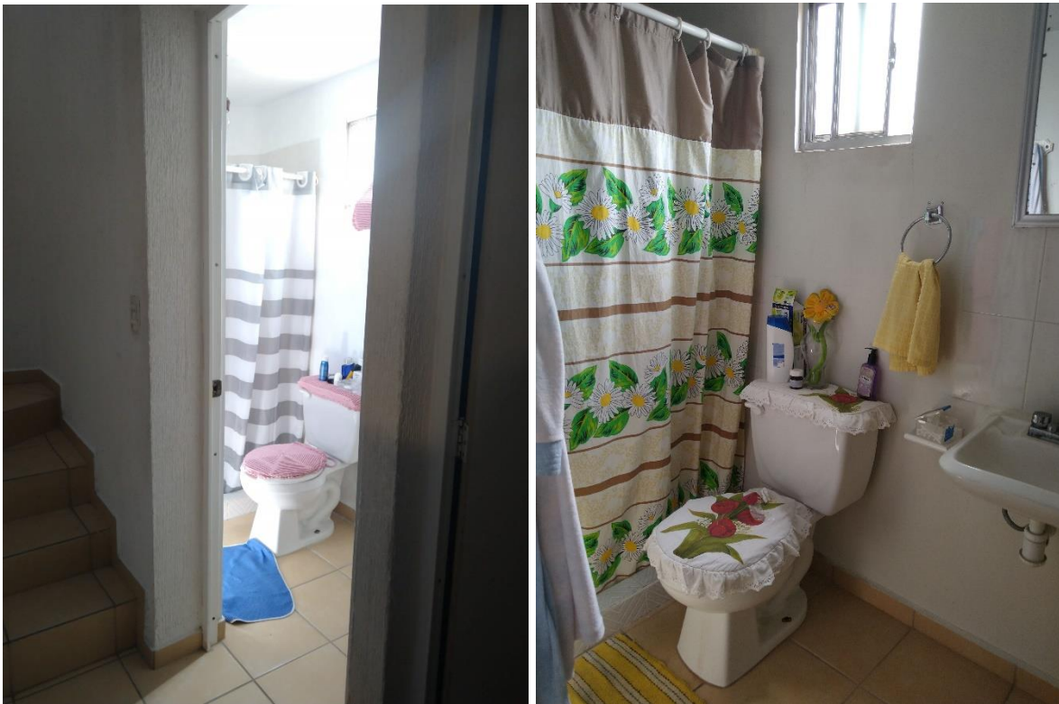
Imagen 121. Abatimiento de la puerta que demuestra como expone el wc. Imagen 122. Espaciamento entre los muebles correctamente. Fuente: Fotografía tomada por autor, 2020
