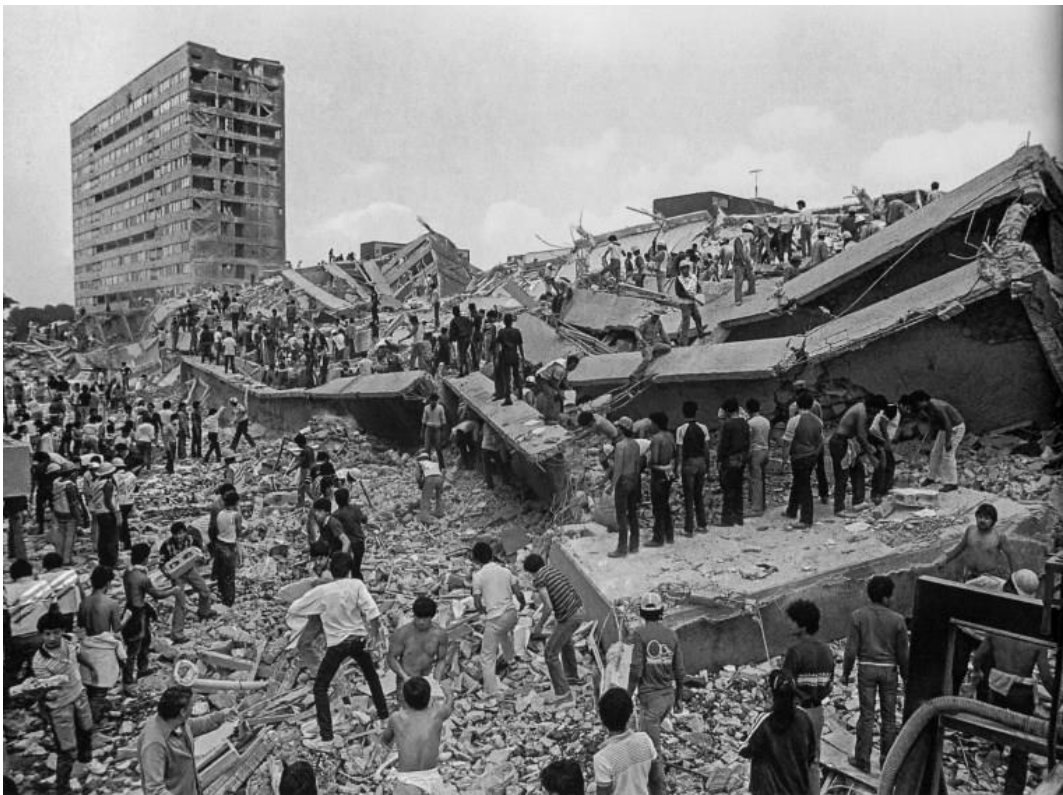
Imagen 8. Edificio Nuevo León, Tlatelolco, 19 septiembre 1985. Fuente: Fotografía propiedad de Marco Antonio Cruz
