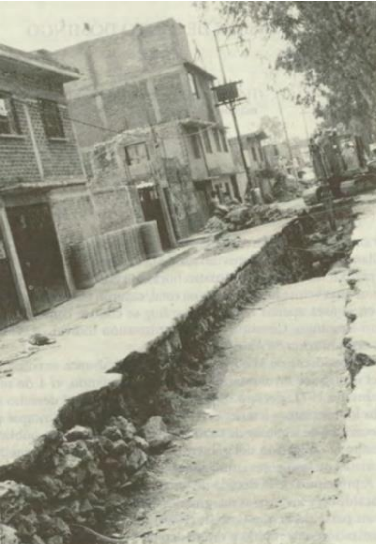
Imagen 23. Construcción del Drenaje de aguas negras en Pedregal de Santo Domingo. Fuente Fotografía propiedad de: Gutmann, Matthew C. 2017
