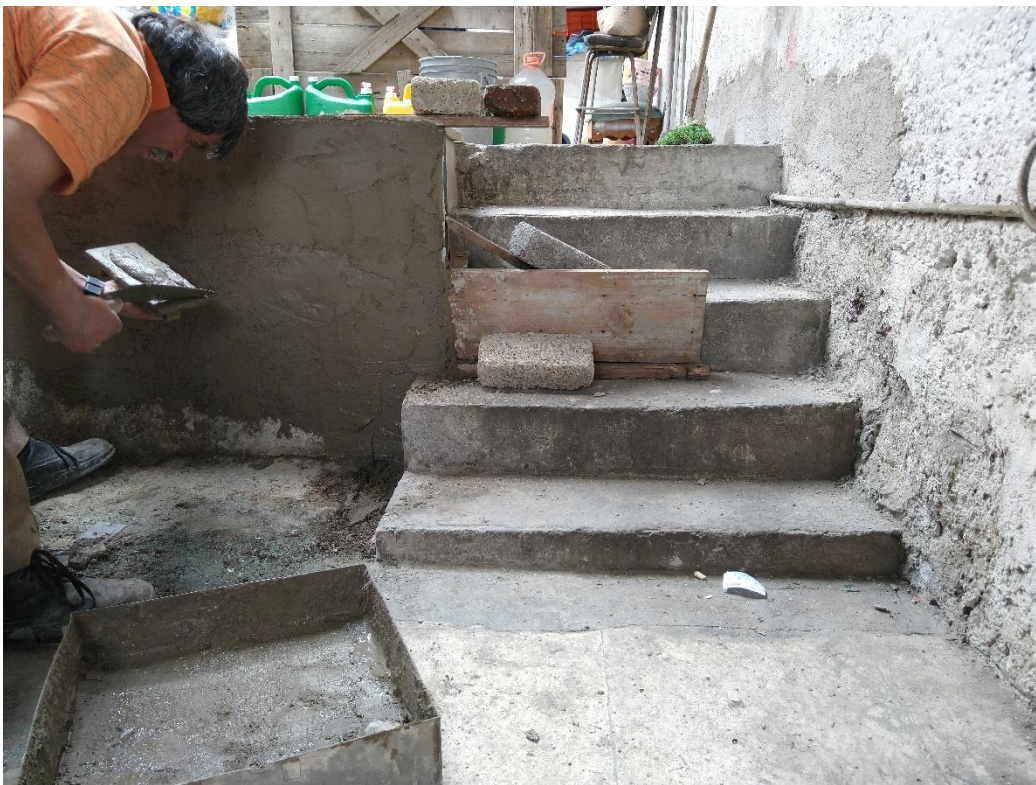
Imagen 51. Reparación del registro sanitario. Fuente: Fotografía tomada por autor, 2020
