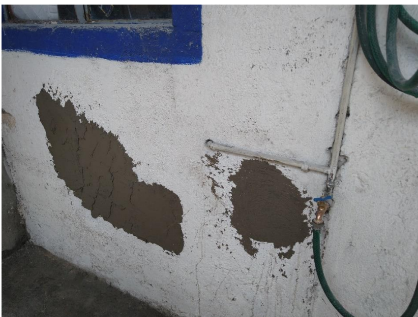
Imagen 60. Aplanado de mortero en imperfecciones de los muros. Fuente: Fotografías tomadas por autor, 2020
