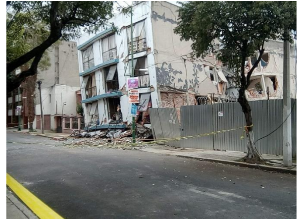
Edificio colapsado CDMX Fuente: tomada por autor
