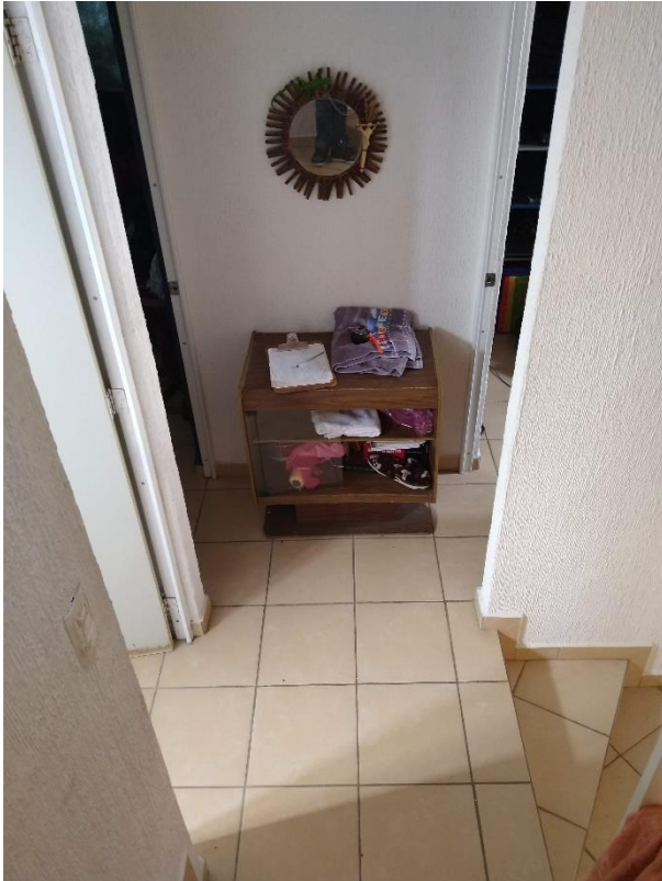
Imagen 117. Vestíbulo con medidas mínimas y con mueble que obstruye salidas de las recámaras. Fuente: Fotografía tomada por autor, 2020.
