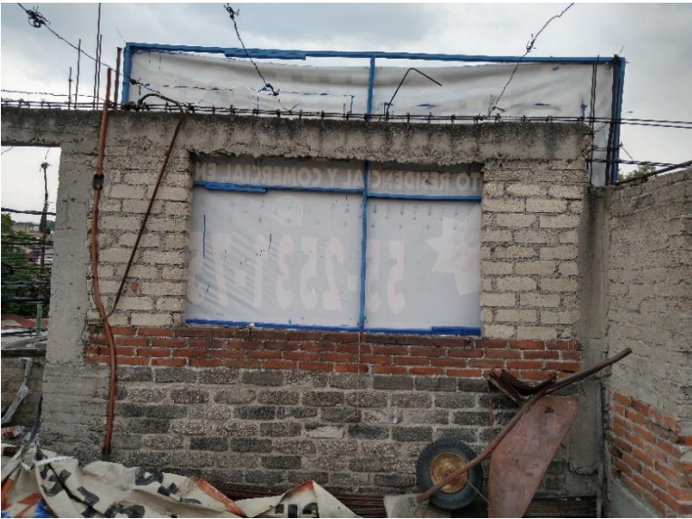
Imagen 41. Muros con sus vanos y cadenas de cerramiento en planta alta. Fuente: Fotografía tomada por autor, 2020
