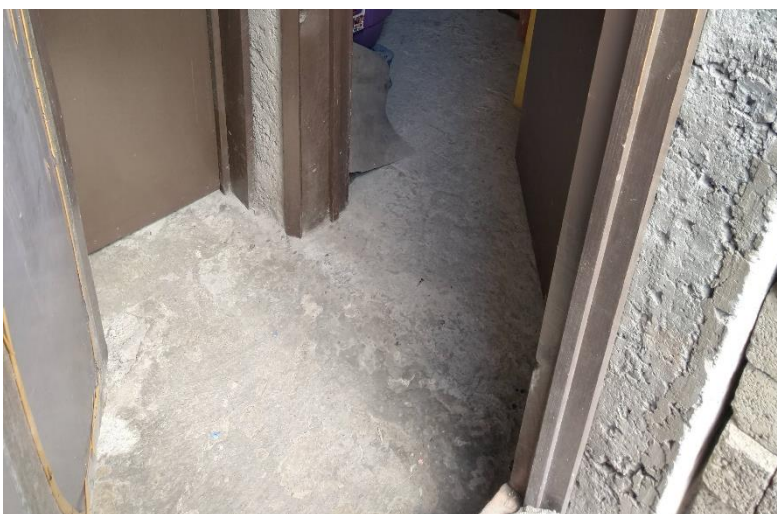
Imagen 75. Vestíbulo para acceder a los cuartos, se nota que el abatimiento de la puerta es justa Fuente: Fotografía tomada por autor, 2020
