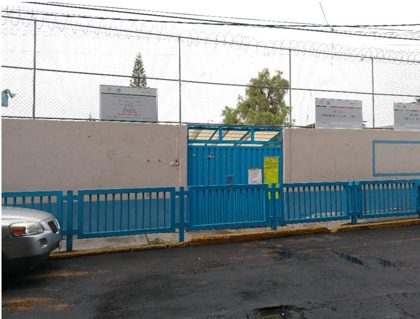
Imagen 91. Acceso a escuela primaria. Fuente: Fotografía tomada por autor, 2020
