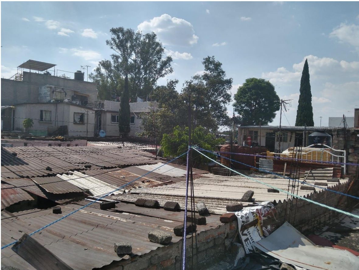
Imagen 25. Vista desde los techos, a la lejanía el mismo tipo de vivienda. Fuente fotografía tomada por autor, 2020
