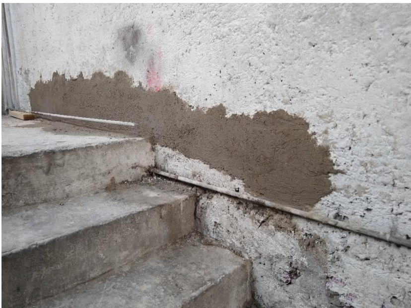
Imagen 49. Tuberías sin funcionamiento de la cual una está recortada Fuente: Fotografía tomada por autor, 2020
