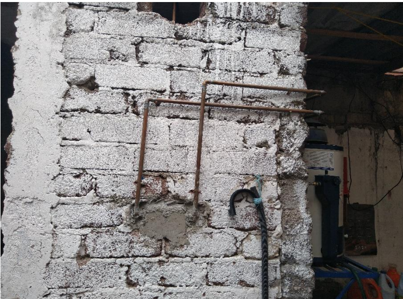
Imagen 55. Tuberías de cobre entrando al baño Fuente: Fotografía tomada por autor, 2020.
