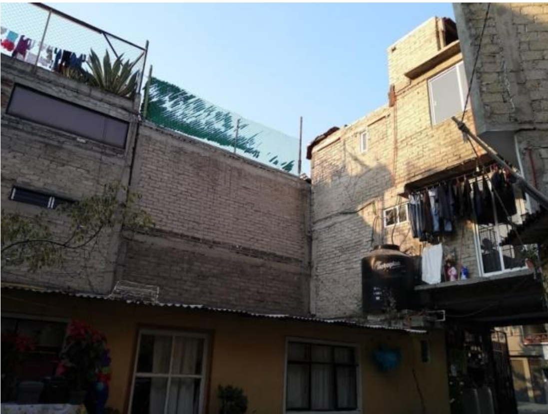
Imagen 26. Vivienda Autoconstruida en Colonia Ajusco, la cual en la actualidad sigue su autoconstrucción en proceso. Fuente: fotografía propiedad de Martínez Ávila José Miguel, 2018
