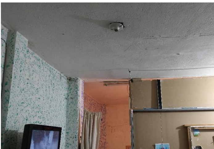
. Imagen 62. Muros y techo con aplanado de mortero. Fuente: Fotografía tomada por autor, 2020
