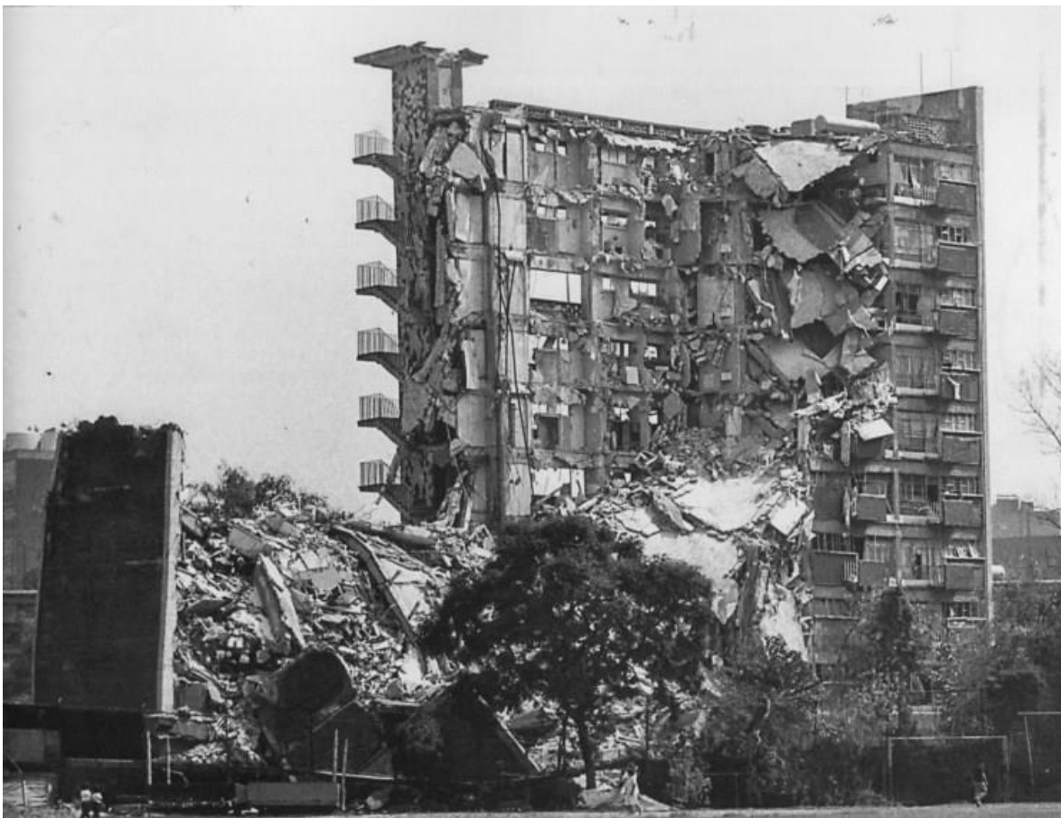
Imagen 9. Multifamiliar Juárez, 19 septiembre 1985. Fuente: Fotografía propiedad de Archivo Excelsior
