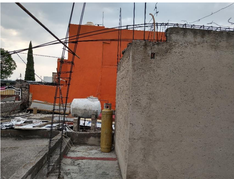
Imagen 42. Muros, cadenas y castillos planta alta. Fuente: Fotografía tomada por autor, 2020
