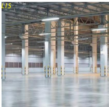
Luminaria lineal sobrepuesta en plafón. Se propone un sistema de control de tipo on/off a través de un sensor de presencia en muro.
