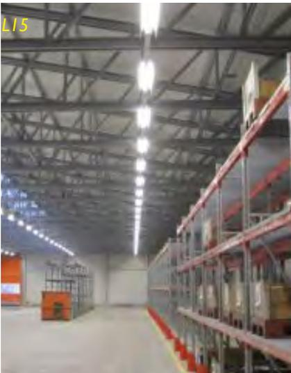
Luminaria lineal sobrepuesta en plafón. Se propone un sistema de control de tipo on/off a través de un sensor de presencia en muro.
