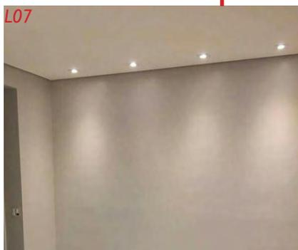
Iluminación general a través de luminarias empotradas en plafón. Se propone un sistema de control on/off con atenuación.
