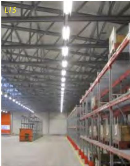
Luminaria de lineal sobrepuesta en plafón . Se propone un sistema de control on/off.
