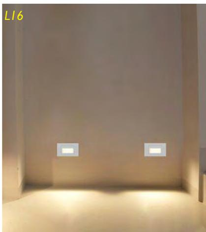
Luminaria de cortesía en muro. Se propone un sistema de control de tipo on/off a través de un sensor de presencia en pared.
