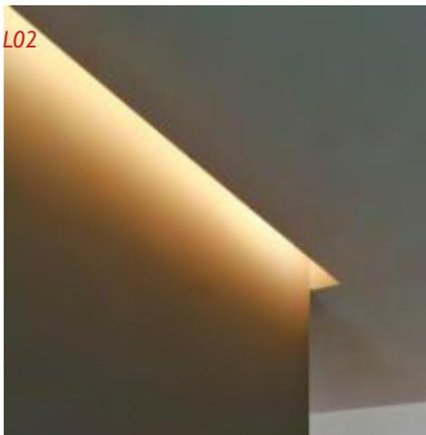
Luz rasante en muro para resaltar elementos decorativos. Se propone un sistema de control de tipo on/off.
