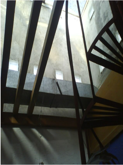
Imagen 30 - Concreto y escaleras de acero, elaboración propia.
