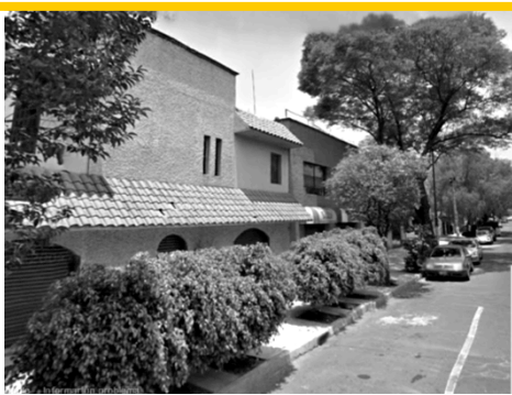
Imagen 20- edificio 1 fachada Hernández y Dávalos, elaboración propia.
