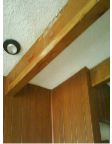
Imagen 32 - Muros forrados de madera, elaboración propia.
