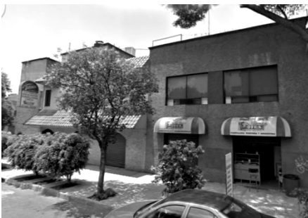
Imagen 41 - Vista hacia el edificio 1 desde Hernández y Dávalos Elaboración propia
