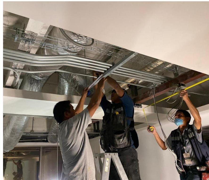
Imagen 42 Tubería y charofil
