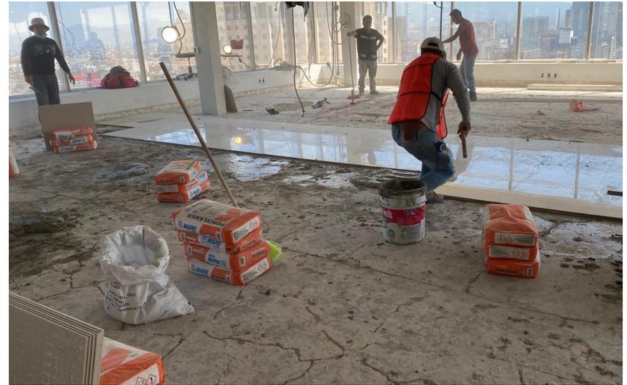
Imagen 32 Colocación de piso cerámico
