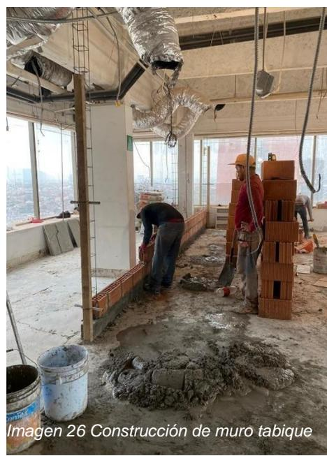
Imagen 26 Construcción de muro tabique
