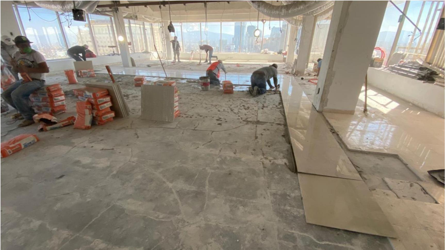
Imagen 31 Colocación de piso cerámico en área común
