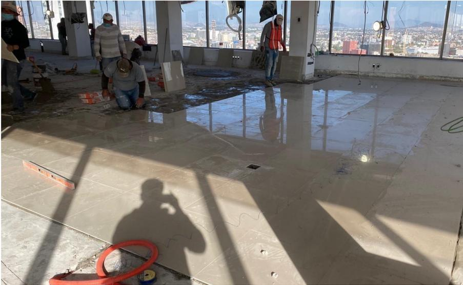
Imagen 33 Colocación de piso cerámico
