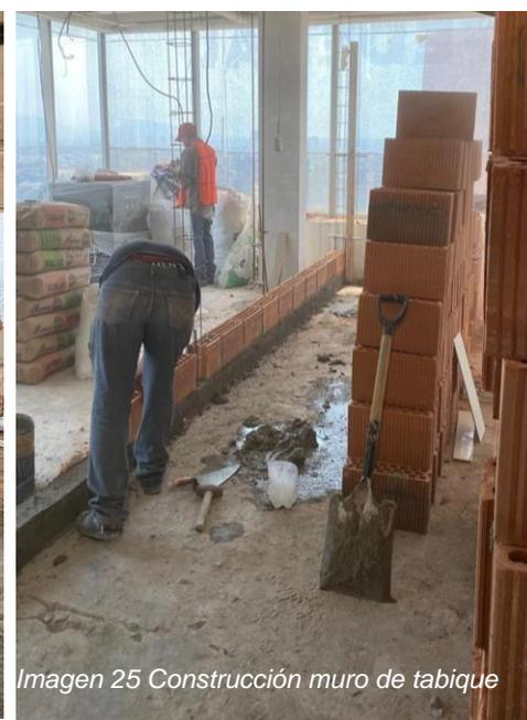
Imagen 25 Construcción muro de tabique
