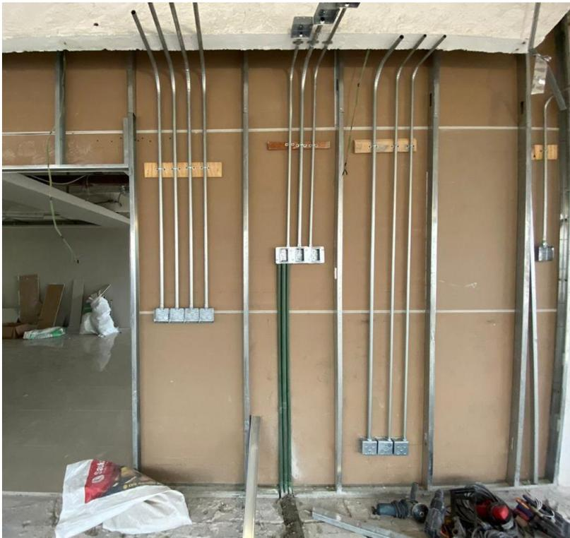
Imagen 43 Tubería para instalación eléctrica
