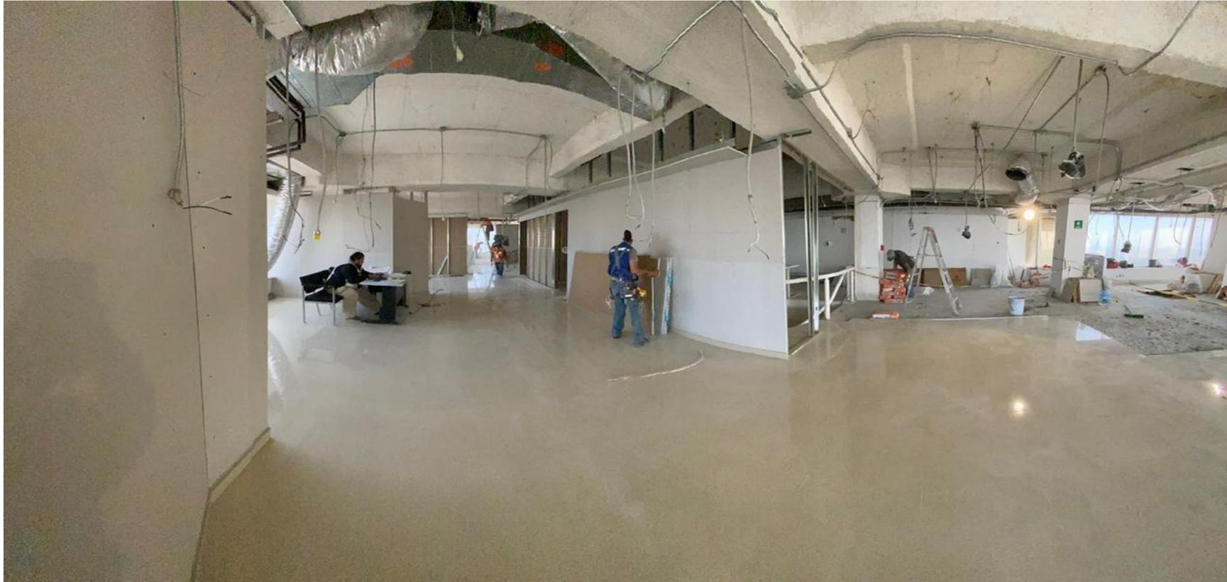
Imagen 36 Colocación de muros de yeso
