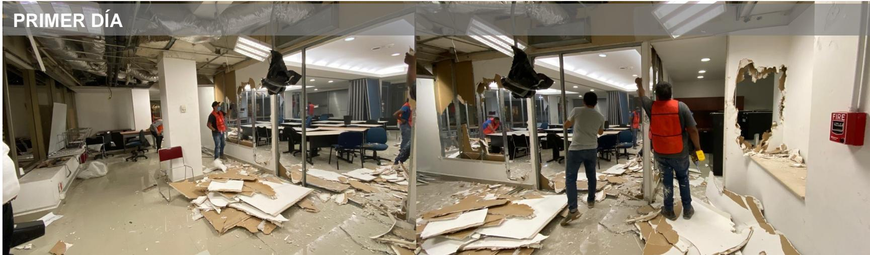
Imagen 9 Demolición de muros y plafón
