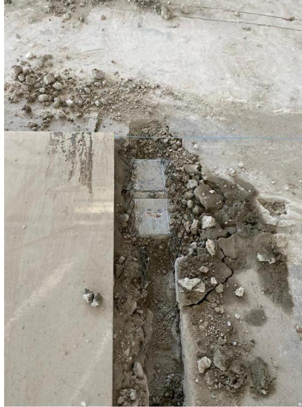
Imagen 23 Ranura para paso de instalación eléctrica
