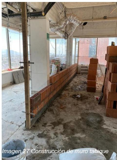
Imagen 27 Construcción de muro tabique
