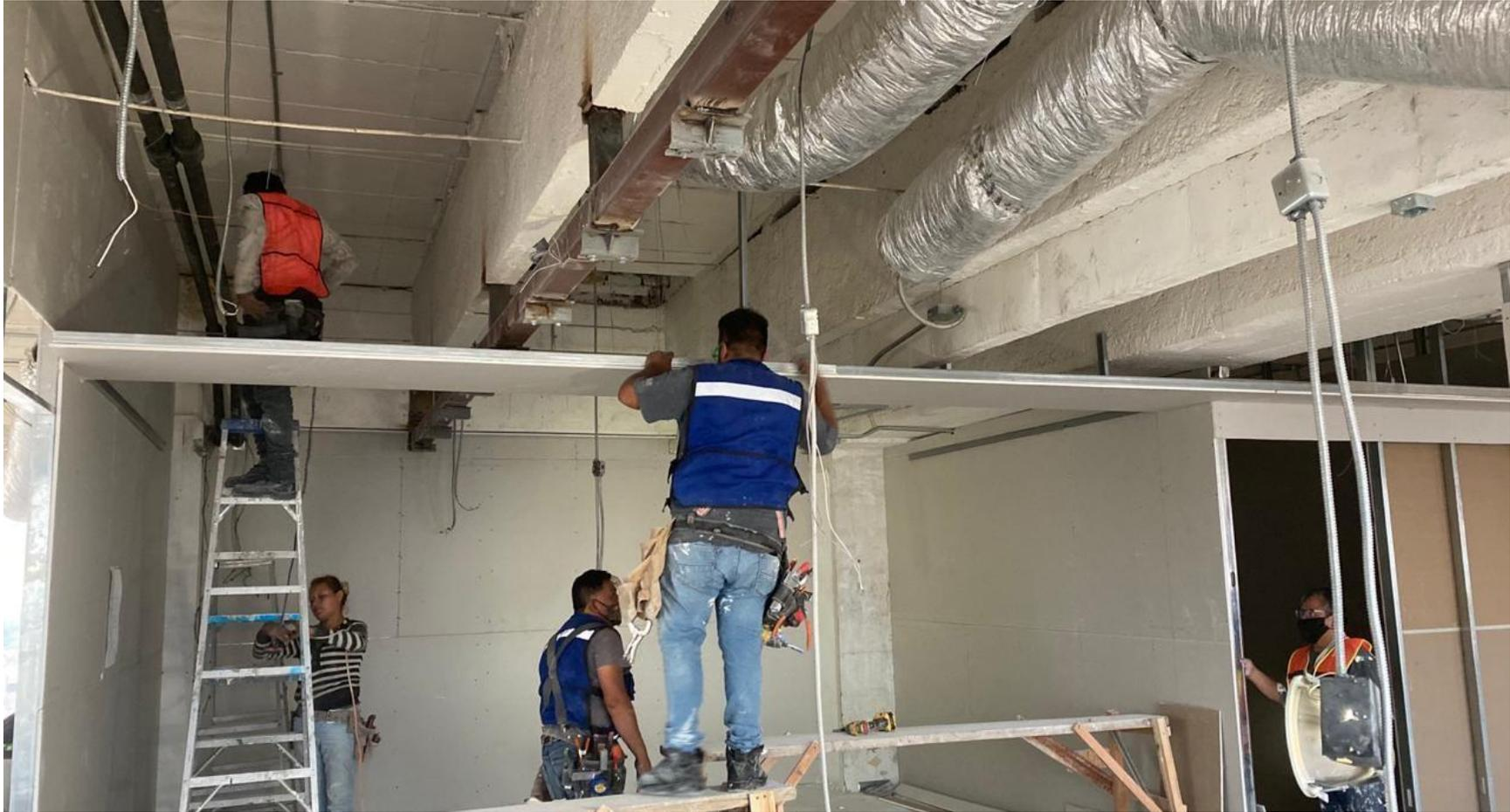
Imagen 41 Colocación de platabanda
