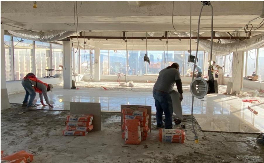
Imagen 35 Colocación de piso cerámico
