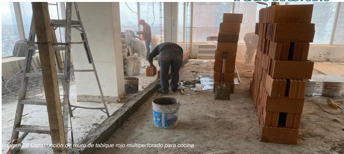
Imagen 29 Construcción de muro de tabique rojo multiperforado para cocina
