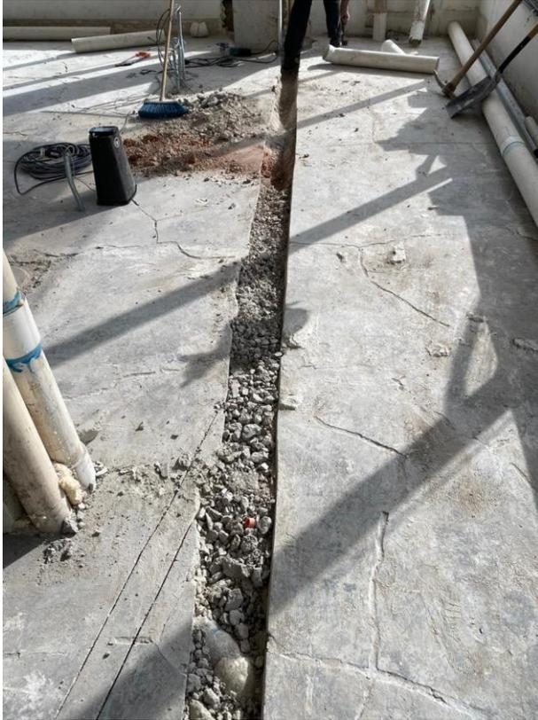
Imagen 24 Ranura para paso de instalación sanitaria
