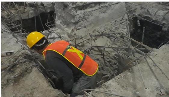
a) Demolición del concreto original
