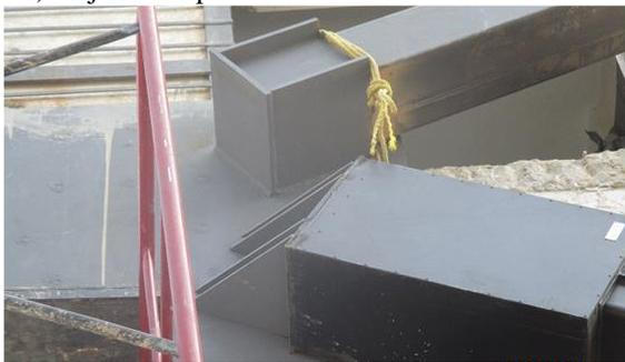
e) Conexión donde converge un dissipador y un contraventeo convencional
