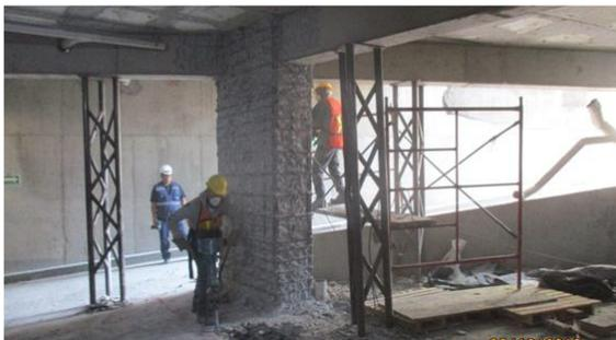
a) Escarificación de columnas de concreto
