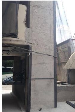
a) Colocación de los ángulos en las esquinas de la columna
