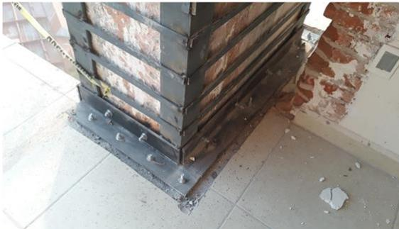
c) Detalle del anclaje al sistema de piso
