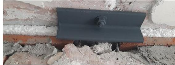
b) Colocación de ángulos para evitar falla fuera de plano
