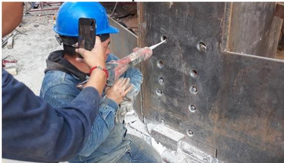
e) Colocación de anclaje químico a la placa de refuerzo
