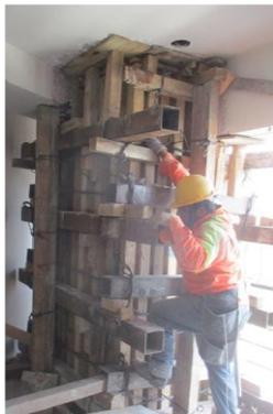
e) Inicio del encofrado de la columna
