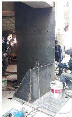
a) Colocación de placa de conexión
