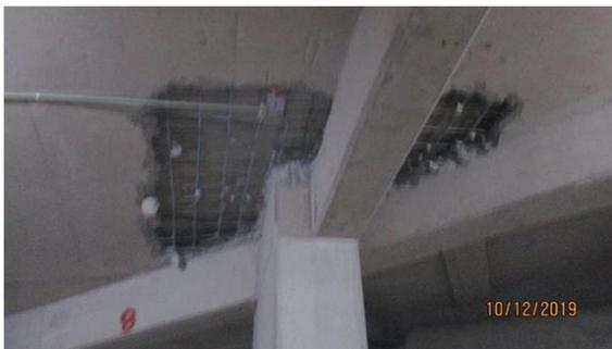
a) Demolición de la losa existente
