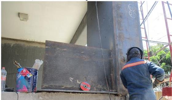
c) Colocación de la placa de conexión en N1
