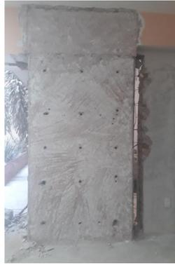
a) Perforación de la columna para el anclaje necesario para el emplacado
