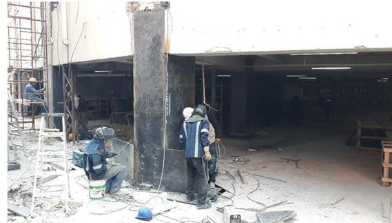
d) Adosamiento de la placa de conexión del dissipador al emplacado de la columna
