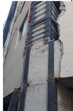
d) Colocación de los ángulos en una transición de secciones
