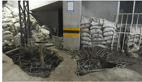
d) Habilitado entre el acero de refuerzo de las pilas y de los dados
