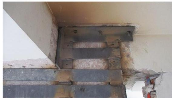
f) Detalle frontal del anclaje del refuerzo con la trabe de concreto
