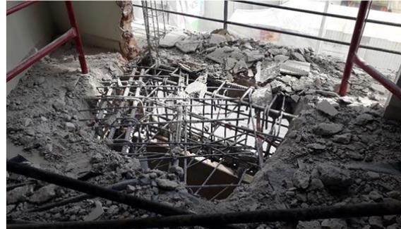
b) Demolición del sistema de piso
