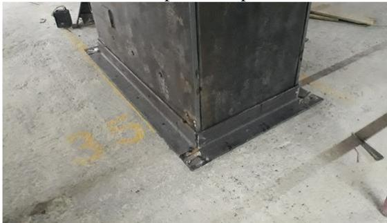
c) Detalle del anclado del emplacado al sistema de piso
