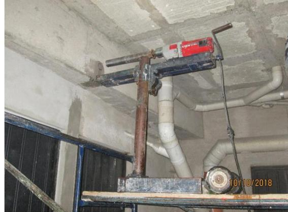
b) Extracción de núcleo de concreto en trabe
