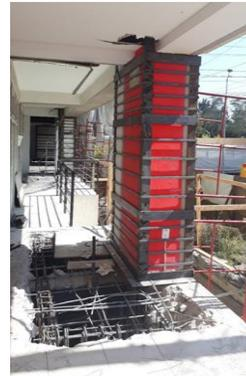
b) Interacción entre el refuerzo de ángulos y soleras y la construcción de los capiteles
