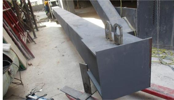
b) Detalle de la conexión de punta para el contraventeo convencional
