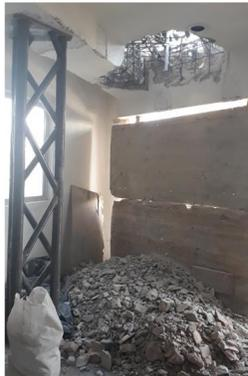
c) Demolición del sistema de piso y de los muros colindantes
