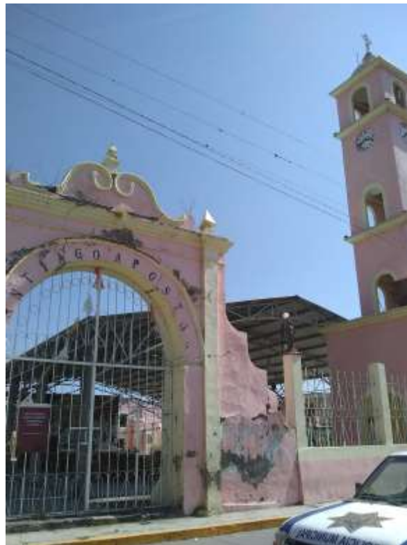
Figura 25. Iglesia en mal estado en Santiago Atzitzihuacán
