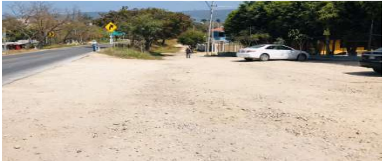
Figura 11 – Estado actual del derecho de vía, km 10+450, de la carretera Panamericana, (Berriozábal, Chiapas).
