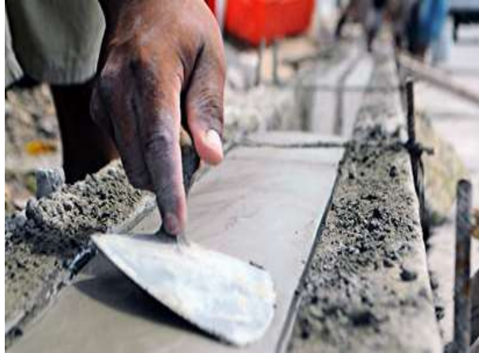
Figura 81 – Acabados de guarniciones.
