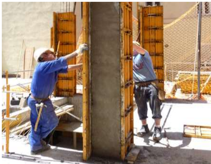
Figura 66 – Encofrado y desencofrado de elementos estructurales.
