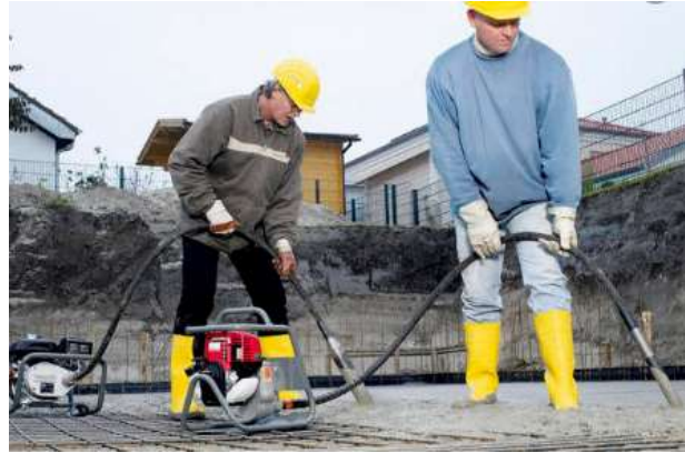
Figura 53 – vibrado del concreto.
