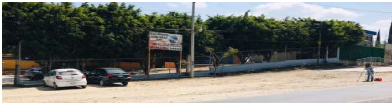
Figura 10 – Acceso principal de la escuela preparatoria “SALOMÓN GONZÁLEZ BLANCO”, (Estado actual).
