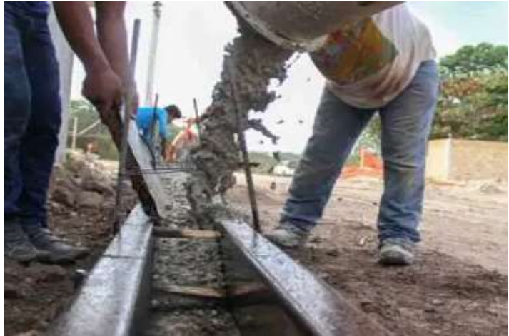
Figura 80 – Construcción de Guarniciones.
