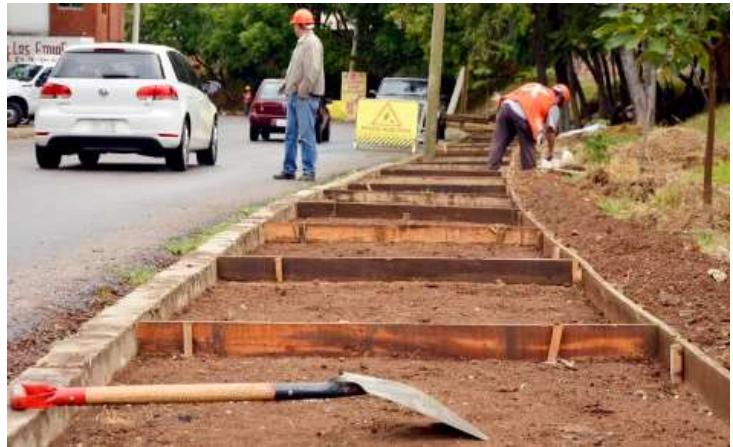
Figura 78 – Construcción de Banquetas.
