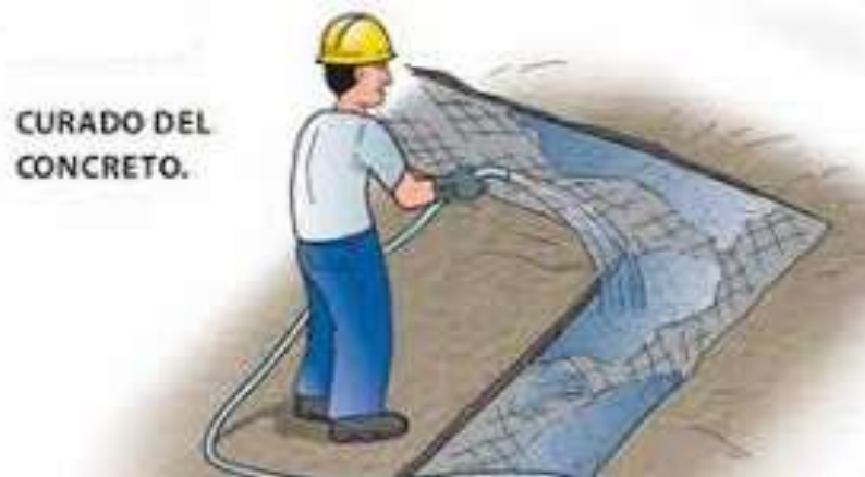
Figura 54 – Curado del concreto.
