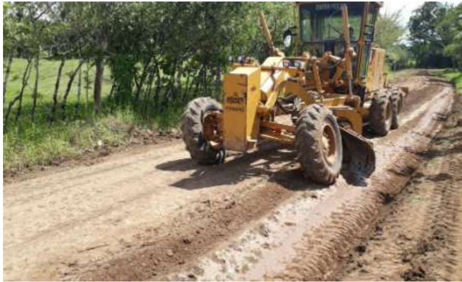
Figura 71 – Excavación, nivelación de cunetas.
