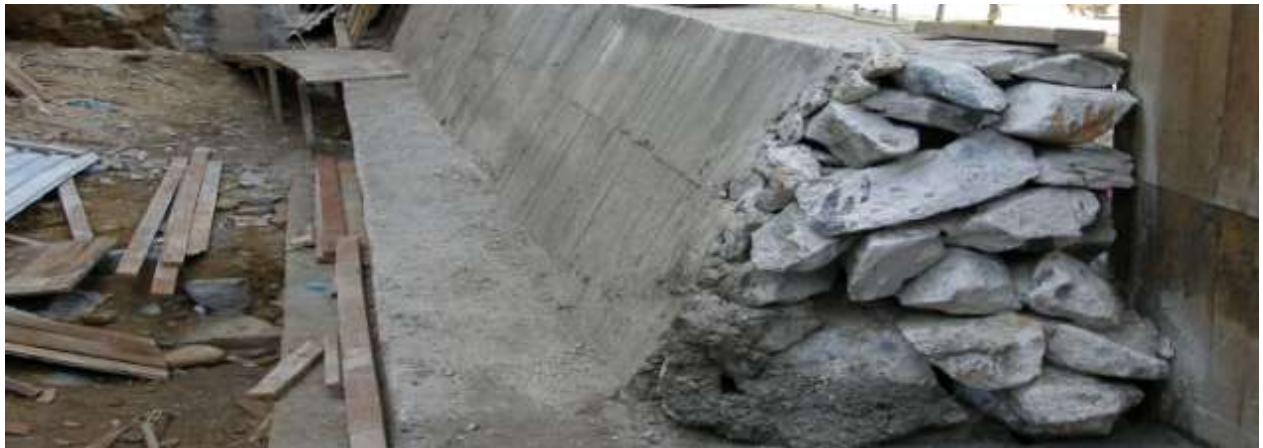
Figura 48 – Muro de concreto ciclópeo.
