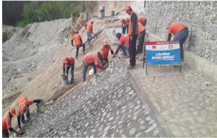
Figura 74 – zampeados en taludes.
