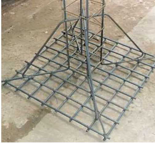
Figura 61 – Habilitado de Zapata.
