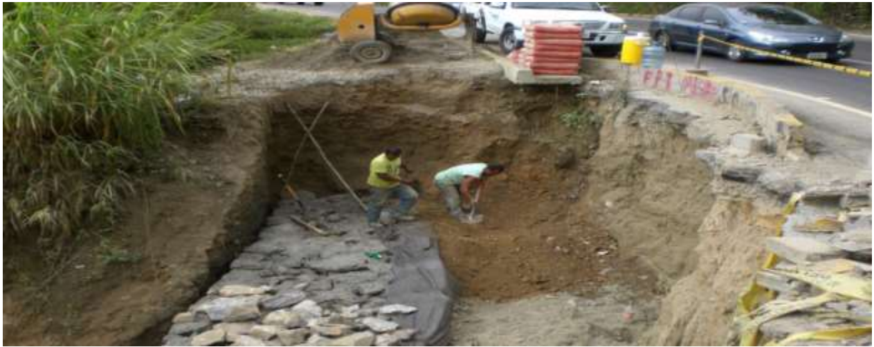
Figura 47 – Base de muro de concreto ciclópeo.
