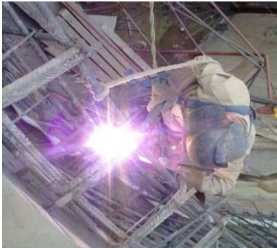
Figura 63 – Aplicación de la soldadura.
