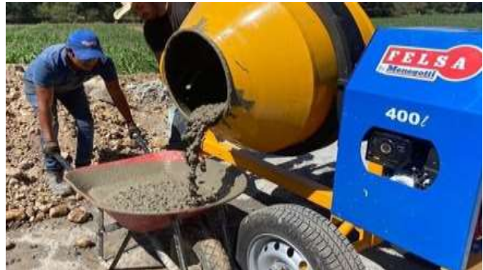
Figura 50 – Concreto hecho en obra.
