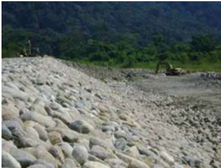
Figura 72 – Zampeado seco.
