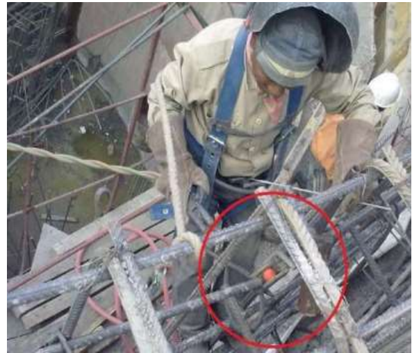
Figura 64 – Punto de soldadura.
