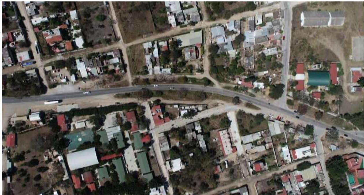
Figura 6 – Imagen aérea de tramo carretero consistente del km 10+350 al 10+850 de la carretera panamericana ubicada en el municipio de Berriozábal, Chiapas.
