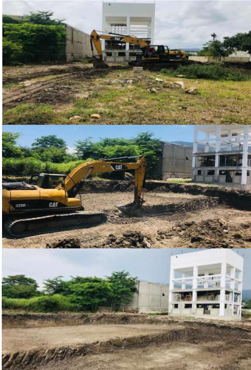
Figura 83 – Excavaciones para estructuras.
