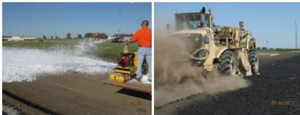
Figura 2.14 Distribución de fibras utilizando un soplador de paja sobre material granular y mezcla de fibras con material granular con un recuperador (White y Vennapusa, 2013).
