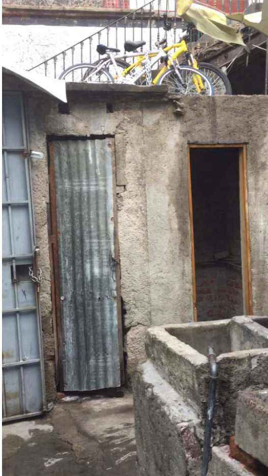
Imagen 10. Antiguos baños comunes en patio
