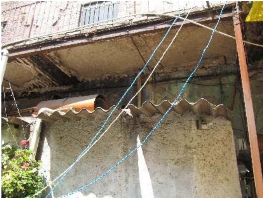
Imagen 26. Apuntalamiento de pasillo. Fuente: Elaboración propia.
