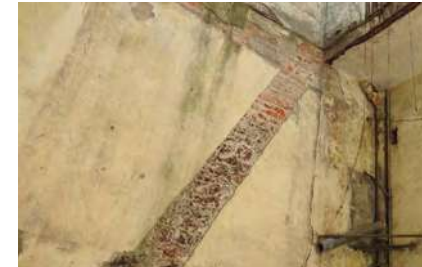
Muro de patio interior y muro de colindancia con casa que muestra piedra brasa al inicio y ladrillo rojo después.
