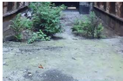
Tierra compactada en el patio central.
