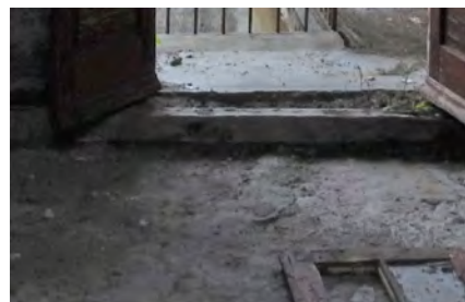
Entrepiso de concreto.
