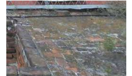
Azotea acabado enladrillado.
