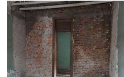
Muro construido después debido al tipo de ladrillo.
