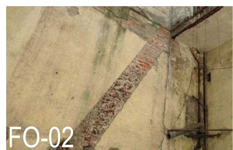
FO-02 MURO MIXTO: PIEDRA BRASA / TABIQUE FOTOGRAFÍA PROPIA TOMADA EN AGOSTO 2019
