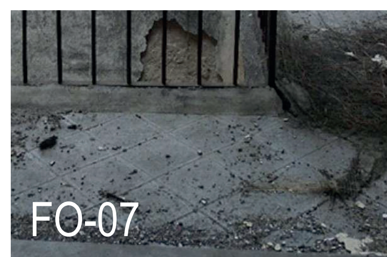
FO-07 PISO DE LAJAS DE PIEDRA 20 X 20cm FOTOGRAFÍA PROPIA TOMADA EN AGOSTO 2019
