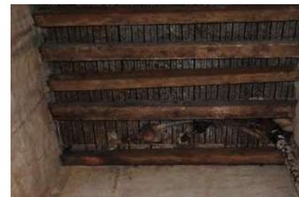
Vigas de madera que sostienen losa de concreto.
