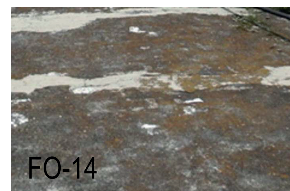
FO-14 LOSA DE CONCRETO, ACABADO CON IMPERMEABILIZANTE
