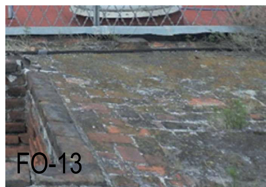
FO-13 LOSA DE CONCRETO, ACABADO CON ENLADRILLADO
