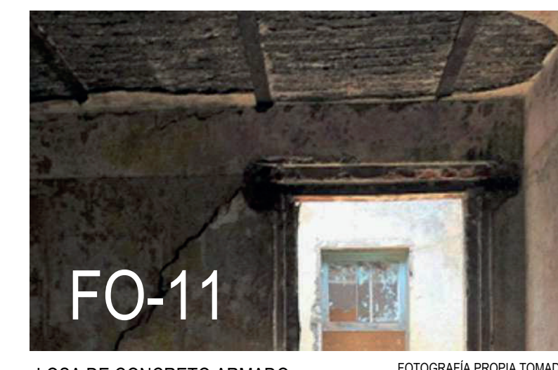
FO-11 LOSA DE CONCRETO ARMADO FOTOGRAFÍA PROPIA TOMADA EN AGOSTO 2019
