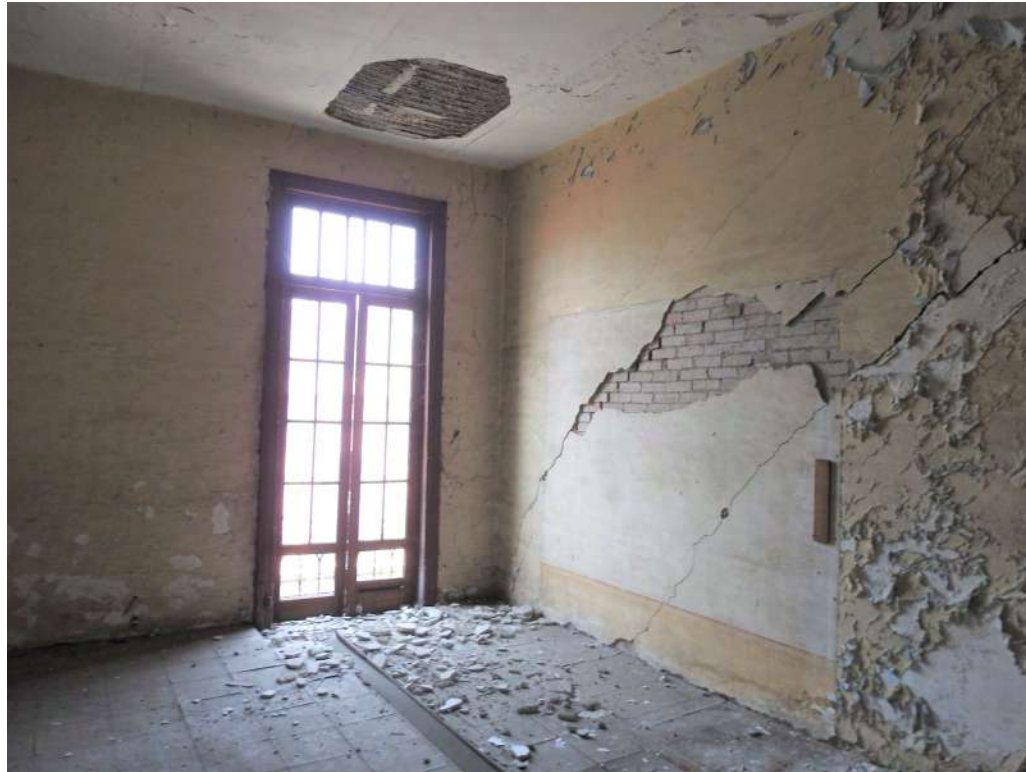
Cuarto con vista a fachada principal, se planea demoler ese muro.
