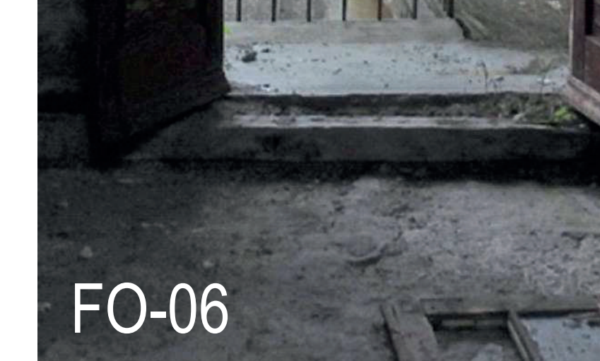
FO-06 ENTREPISO DE LOSA DE CONCRETO 12 cm FOTOGRAFÍA PROPIA TOMADA EN AGOSTO 2019
