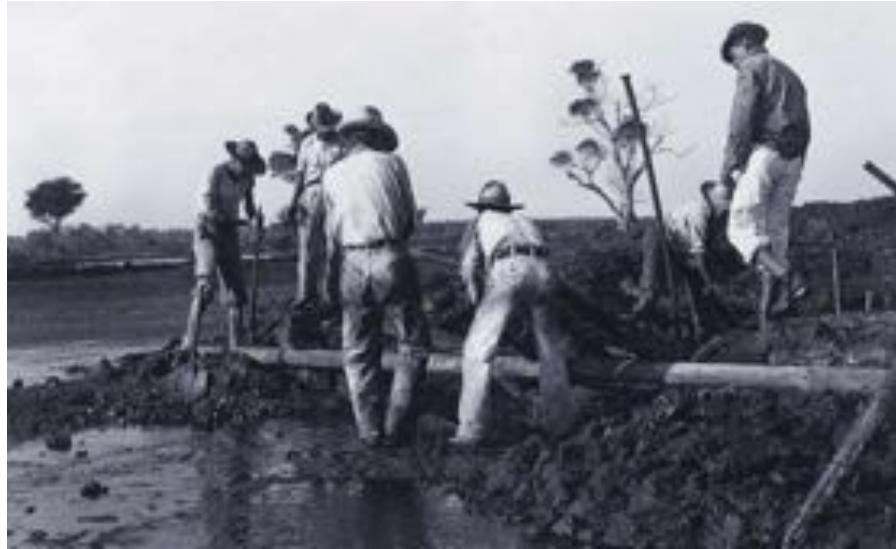
Autoría no identificada Instalación de oleoductos, ca. 1940 Archivo Histórico PEMEX
