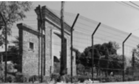
← D) Img. 51 Parque Tulyehualco Espacio de a superficie reducida, es uno de los pocos espacios públicos con los que cuenta el pueblo. Se encuentra invadido por comercio ambulante, lo que perjudica el transito y la estadía. Anteriormente este parque tenía libre paso, sin embargo, debido a la implementación de un arco techo, la delincuencia e inseguridad restringió su acceso a un horario diurno. [Fotografía autoría propia]
