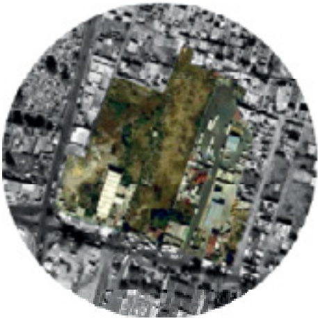
Bloque 3 vista aérea En este conjunto de predios se pueden observar lotes de gran profundidad con construcciones al frente. Se rodea de locales comerciales, casas habitación y tiene como colindancia un equipamiento de salud y el paradero de autobuses y combis flanqueando su frente. Se presenta como un espacio de gran interés para el ordenamiento del paradero permitiendo liberar la vía pública. [google earth 2021]
