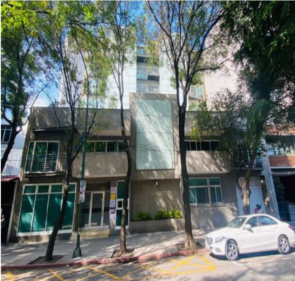
Ilustración 2. Fachada del edificio. Fuente: Elaboración propia
