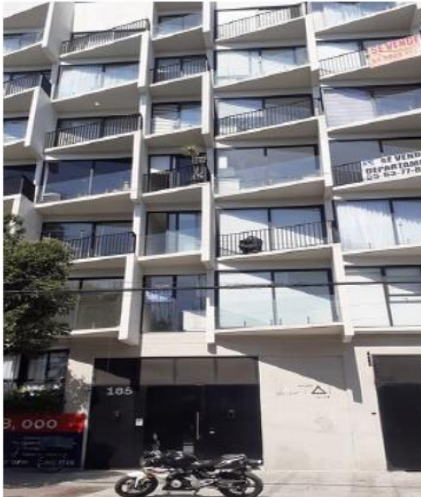
Ilustración 16. Fachada del edificio. Fuente: Elaboración propia
