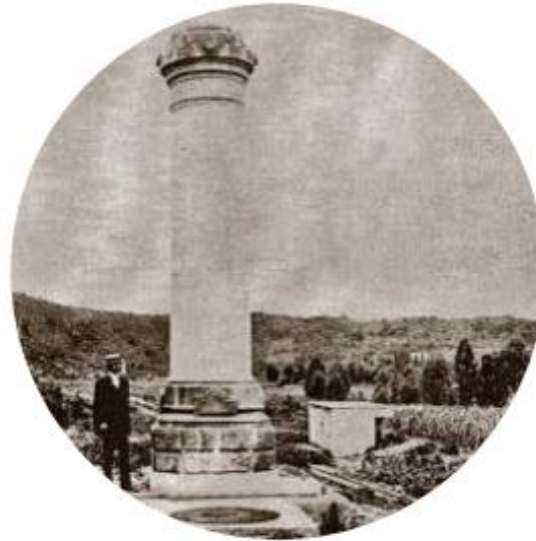
[Imagen 5] Acueducto de Xochimilco.
