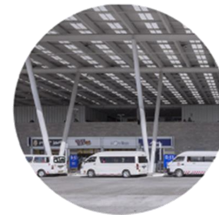
[Imagen 60]: Cubierta con tragaluces
