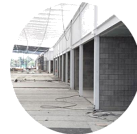
[Imagen 61]: Muros de block hueco y mármol en pisos
