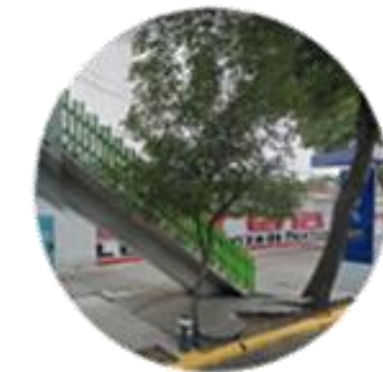
[Imagen 73]: Puente peatonal
