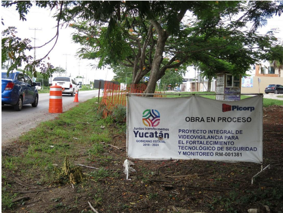
Fotografía 11: Obra en proceso, Proyecto Integral de Videovigilancia por el Gobierno del Estado. África Sevilla. 2021
