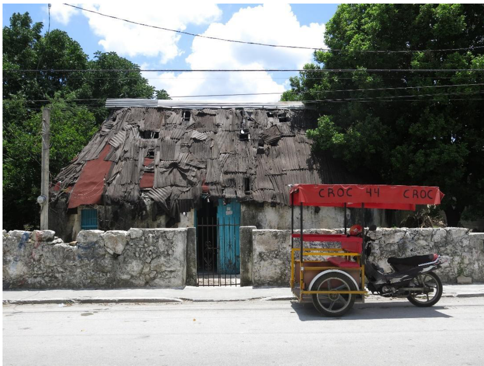
Fotografía 12: Casa habitacional en el pueblo de Conkal. África Sevilla. Septiembre, 2021.
