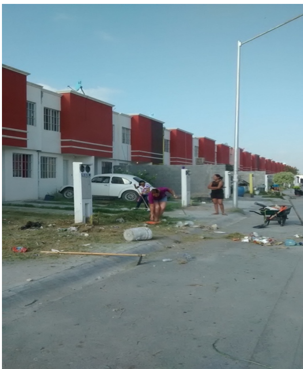
Fotografía 5. Labores de limpieza
