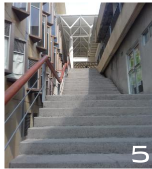
Imagen 28. Área común. Creación propia.
