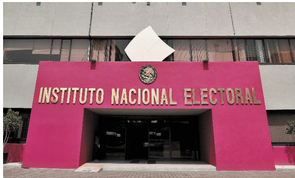
(a) Vista de la fachada.
