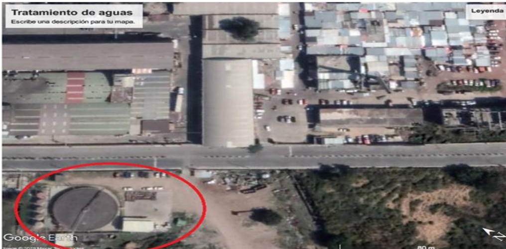
Figura 24 Foto de la Planta de Tratamiento de aguas, Fuente: Google earth 18/07/2019.
