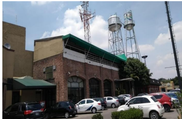
Figura 44 Foto fachada del restaurante se aprecia arcos de ladrillo rojo recocido y cristalería de ventanales de acero, Fuente elaboración propia 2019.
