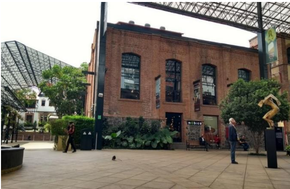
Figura 41 Foto perspectiva interior de uno de los edificios, Fuente: elaboración propia, 2019.
