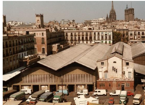
Figura 50 vista posterior de las primeras naves, Fuente: Boqueria.Barcelona/historia-mercat.
