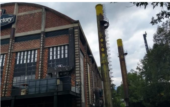
Figura 47 Foto chimenea de la fábrica Fuente elaboración propia, 23/08/19.
