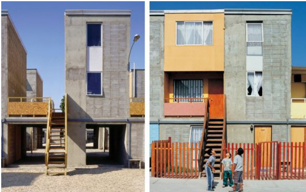
Vivienda progresiva. Propuesta de vivienda diseñada por el despacho del arquitecto Alejandro Aravena en Iquique, Chile 2004.
