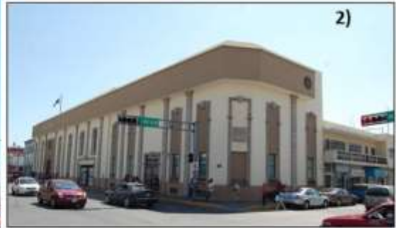
Figura 7. Sede del Congreso del Estado de Nayarit. En 1995 se intervino este inmueble sobre lo ya construido siguiendo el mismo patrón ornamental del Hotel Real de Don Juan. Fuente: Raymundo Ramos.
