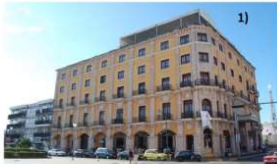
Figura 6. El Hotel Real de Don Juan. Avenida México esquina con Javier Mina. Desde que fue remodelado y ampliado en 1994, ha sido, institucionalmente, el modelo para homogenizar la imagen urbana del centro histórico de Tepic. Fuente: Raymundo Ramos.
