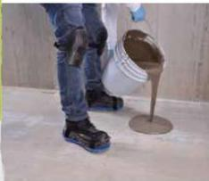
Mortero reforzado fluido para nivelar pisos.
