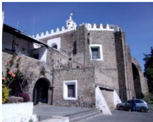
Imagen 34. Muestra la Parroquia Asunción de María. Ubicada en la Avenida Jalisco Oriente de Villa Milpa Alta. Fuente: De mi autoría
