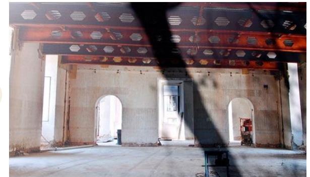
Imagen 61: Vista de los muros de mampostería existentes dentro del Museo.
