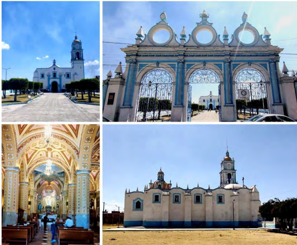
Fig. 43 perspectivas de la iglesia de Santa María Xixitla. En el Cuadro superior derecho arriba los arcos de la entrada principal, a su izquierda la fachada principal, debajo el interior de la iglesia y a su derecha, la vista norte donde también se encuentra un acceso al recinto (imágenes de autoría propia, 2021).
