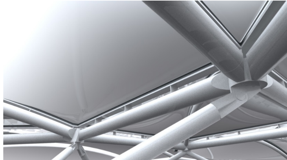
Imagen 83. Cubierta del Beijing Water Cube 2008.
