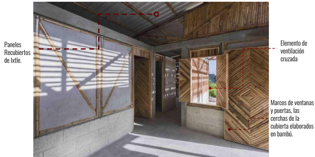
Paneles Recubiertos de lxtle.
