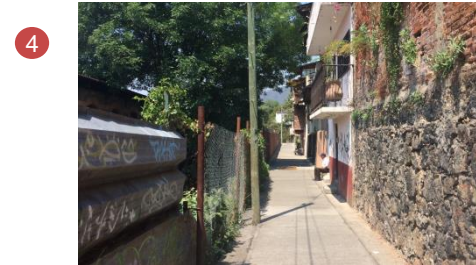
4 Contraste entre la fábrica y las casas en el callejón donde recientemente se levantó un muro de tabique.
