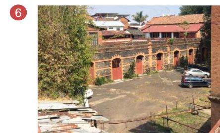
Estado actual de la plaza que divide el volumen de la fábrica del volumen de las bodegas.
