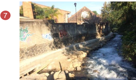
7 Limite de la fábrica con el río, actualmente no existe ninguna relación.
