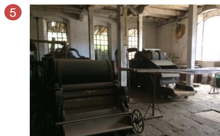
volumen adosado contiene las maquinas que procesaban la materia prima y que preparaban para el proceso de producción
