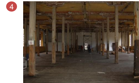
Planta alta de la nave oriente, se observa su sistema de columnas y traves de madera.
