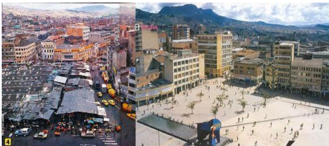
Imagen 7 Fotos del antes y después de la intervención de la Plaza de San Victorino
