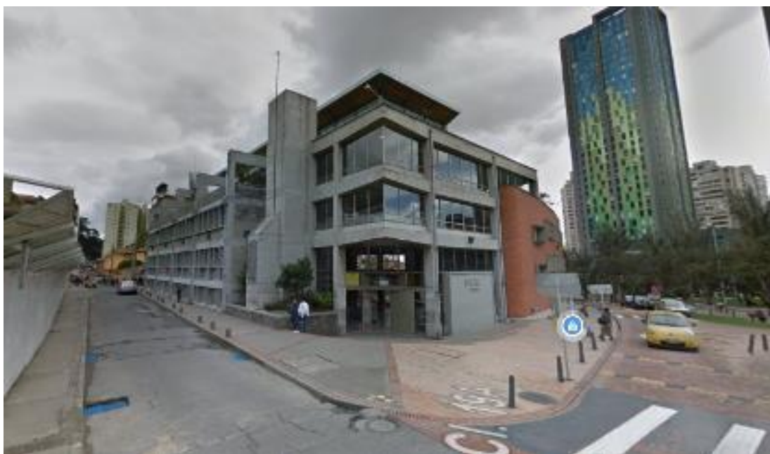
Imagen 21 Edificio Aulas, Universidad de los Andes.
