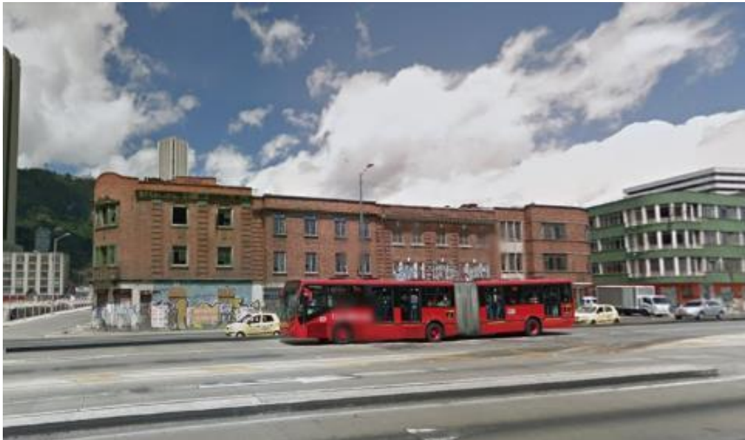
Imagen 13 Conjunto de 4 BIC antes de ser demolidos por el proyecto de Estación Central
