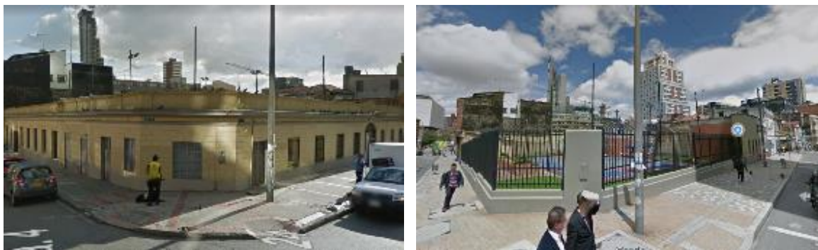
Imagen 19 Comparativo de casa demolida (2015), por la Universidad Jorge Tadeo Lozano para dar paso a una cancha de fútbol (2019)
