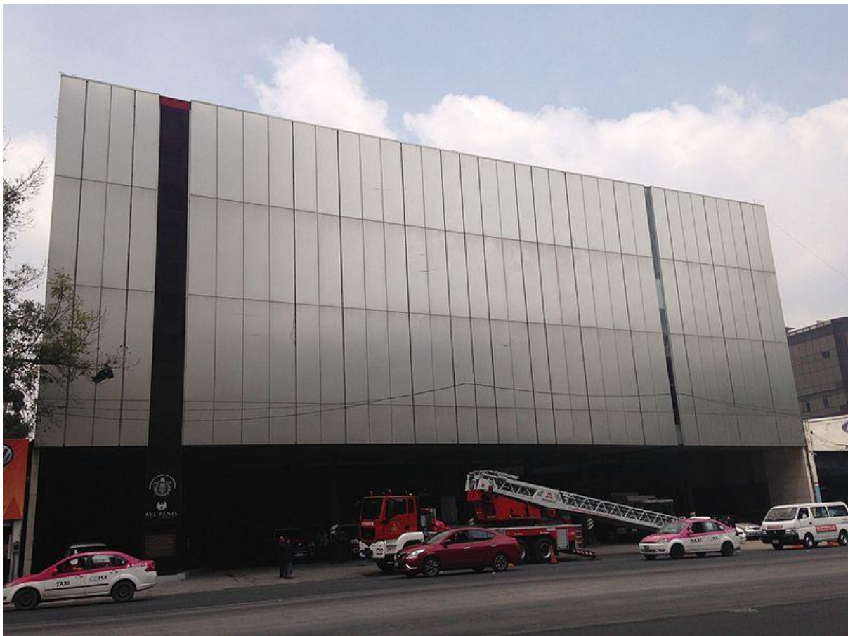
Figura 78: Bernardo Gómez Pimienta Arquitectura + at103, Estación de Bomberos Ave Fénix, Ciudad de México, 2006
