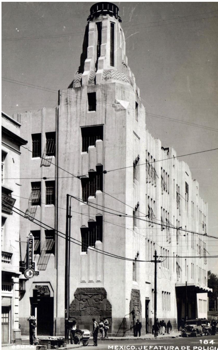
Figura 9: Vicente Mendiola y Guillermo Zárraga, Edificio de la Inspección General de Policía y Cuartel de Bomberos, Ciudad de México, México, 1928
