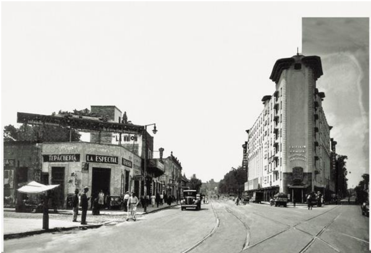
Figura 12: Juan Segura Gutiérrez, Edificio Ermita, Ciudad de México, 1932
