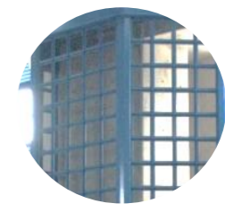
HERRERÍAS: Terminado con pintura de color
