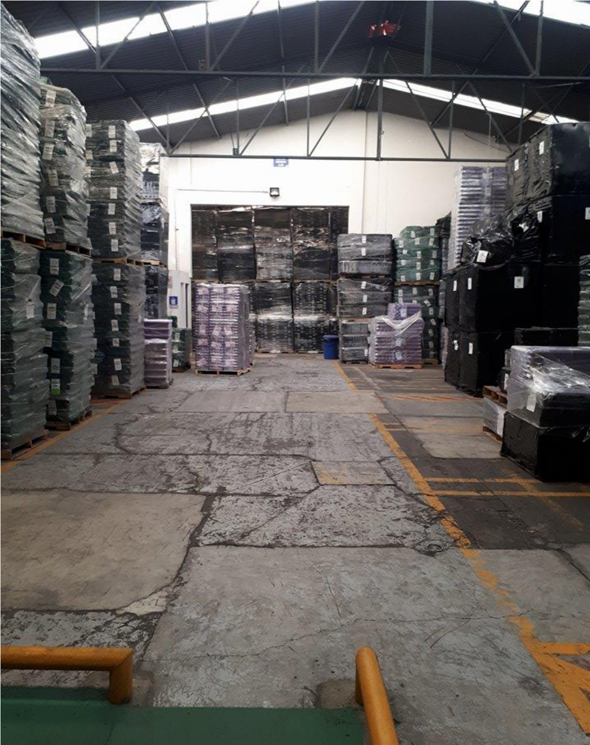
Figura 3.7 Vista general de las condiciones del piso.
