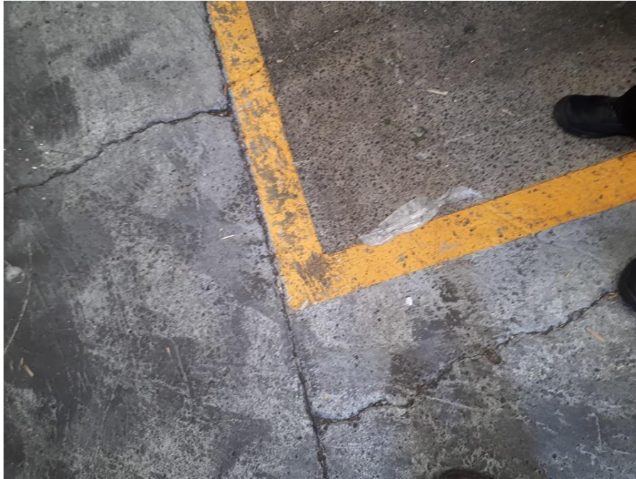
Figura 3.10 Agrietamiento aleatorio.
