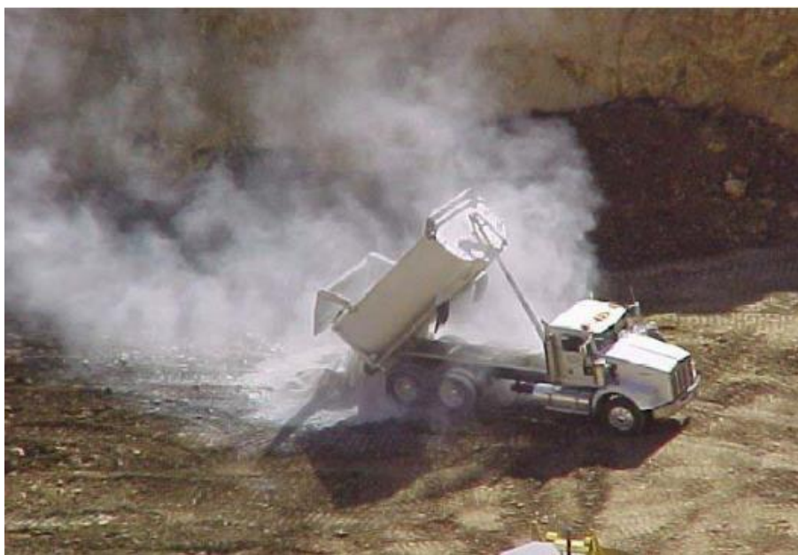
Figura 9. Adición de material neutralizante. (Aduvire, 2006)
